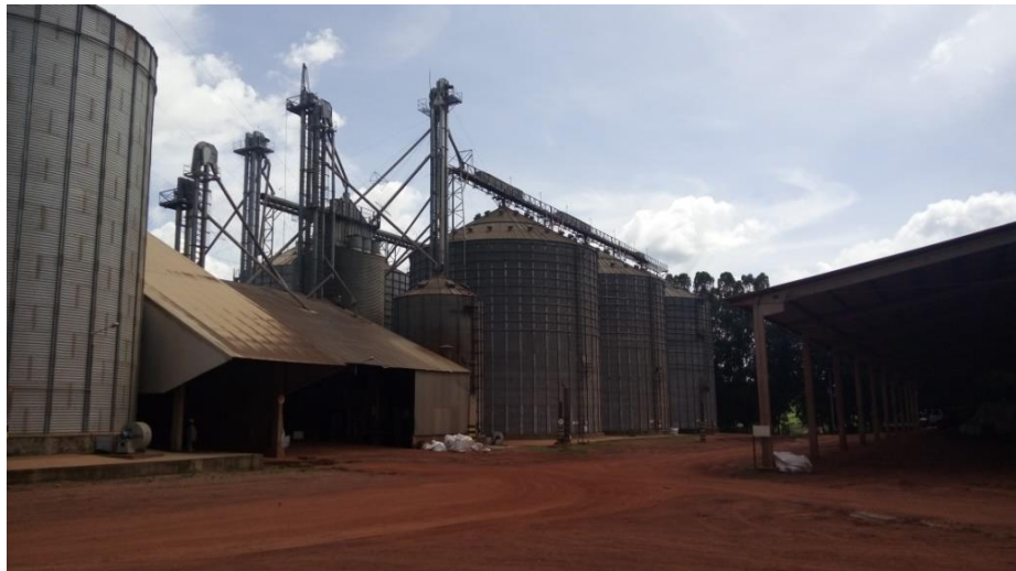
Figura 19: Silos de armazenamento de grãos.
