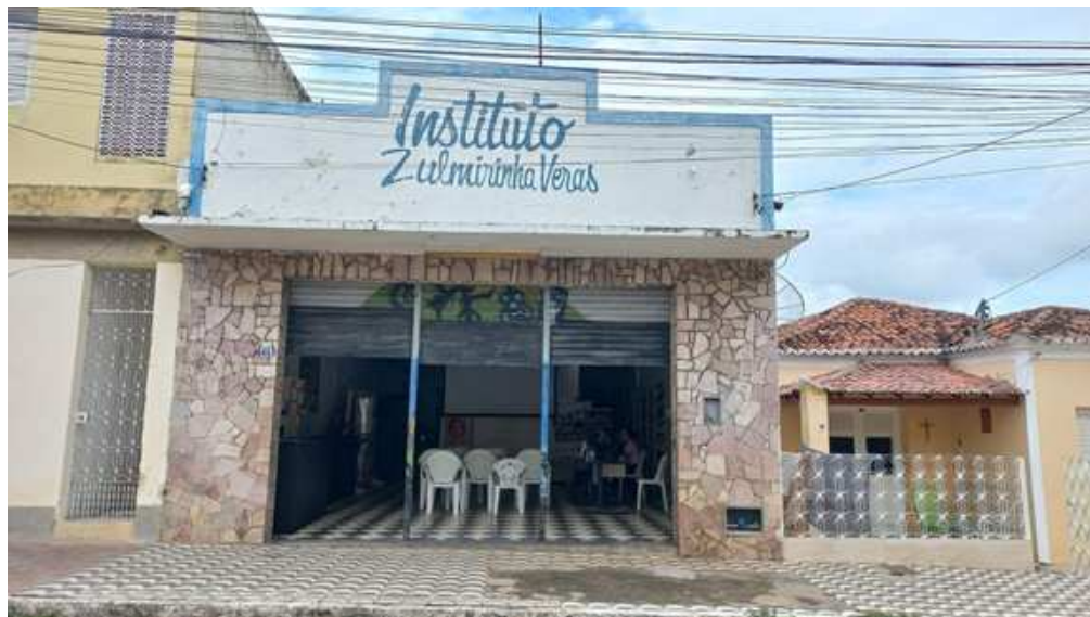
Figura 28 - Fachada do Instituto Zulmirinha Veras
