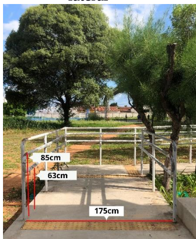
Figura 11 – Início de rampa de acesso ao portão lateral
