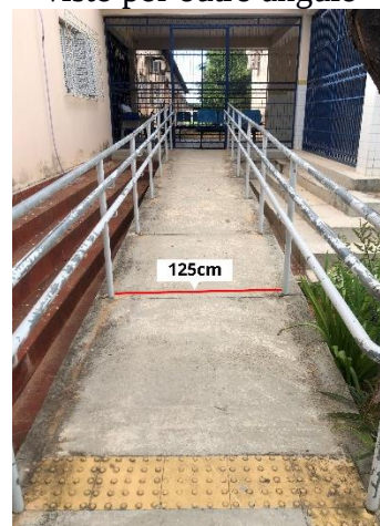
Figura 13 - Rampa de acesso ao portão lateral, visto por outro ângulo
