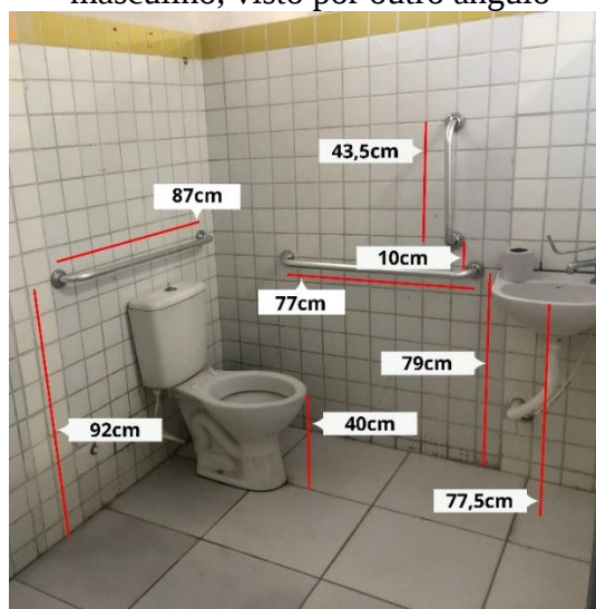
Figura 16 - Boxe de banheiro acessível masculino, visto por outro ângulo
