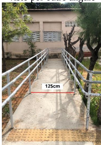
Figura 12 - Rampa de acesso ao portão lateral, visto por outro ângulo
