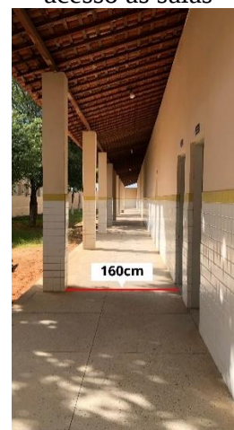
Figura 19 – Corredor de acesso às salas
