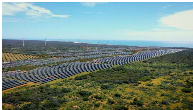
Figura 5. Conjunto Fotovoltaico Floresta I, II e III [9].
