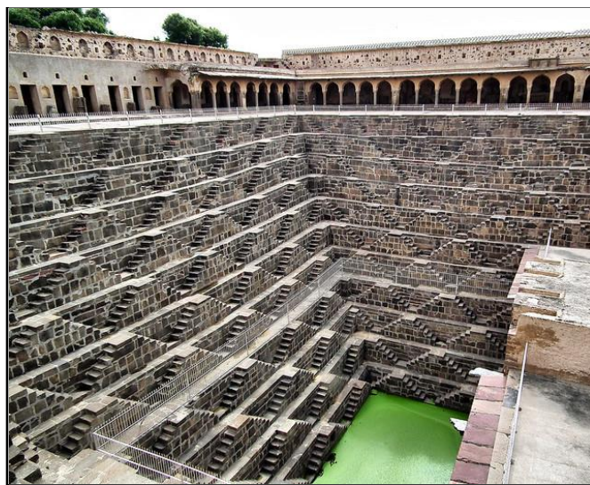
Figura 2 - Poços de escadas
