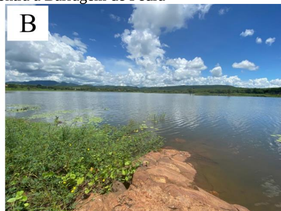
17b – Vegetação crescendo dentro da barragem de Pedra
