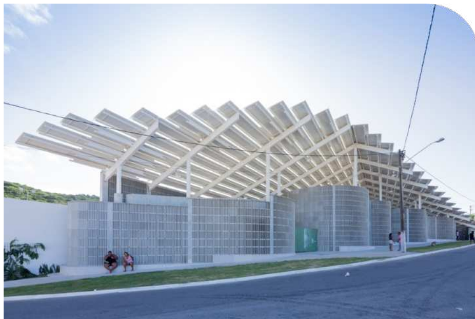
Figura 23 - Fachada principal da Arena do Morro.
