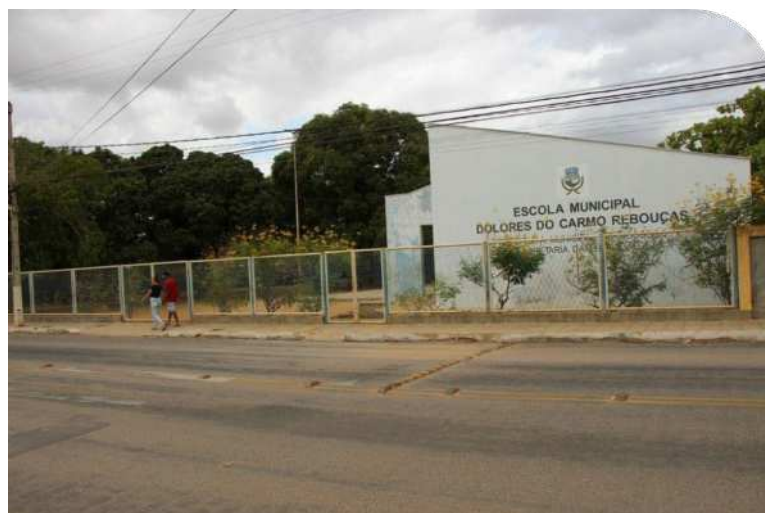
Figura 31 - Escola Municipal Dolores do Carmo Rebouças.
