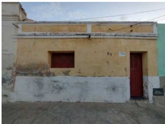
Figura 33 – Fachada frontal Residência 53, Rua José Horácio
