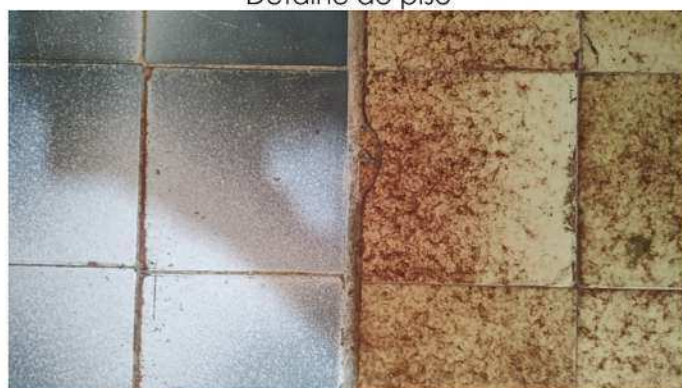
Detalhe do piso
