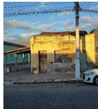
Figura 52 – Residência N/A, Avenida Pedro Matos
