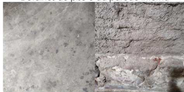
Detalhes do piso e da parede interna
