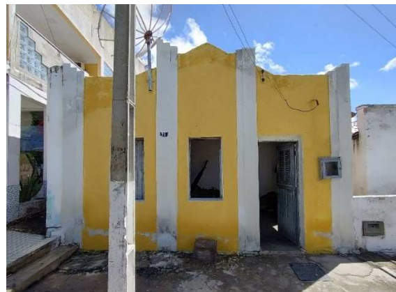
Figura 48 – Residência 21, Rua Valdomiro Teonácio Bezerra
