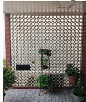
Parede de cobogós
