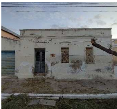
Figura 50 – Residência 45, Rua José Horácio
