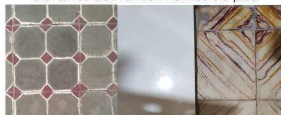
Detalhes dos revestimentos de piso
