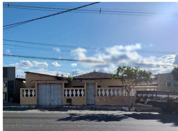
Figura 62 – Residência N/A, Rua Vicente Germano
