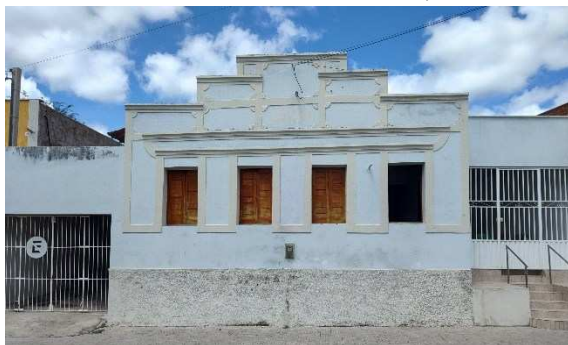
Figura 44 – Fachada da Residência 18, Rua Pedro Moura de Vasconcelos, 2024
