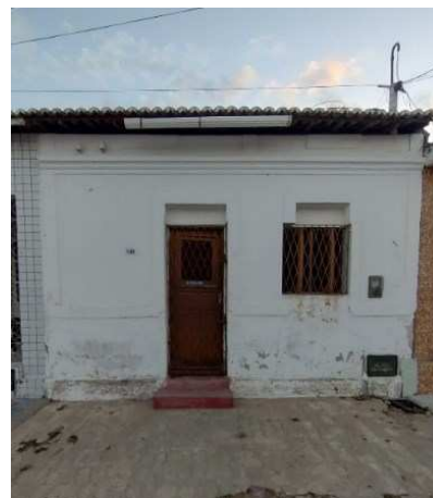
Figura 42 – Residência 91, Rua José Horácio
