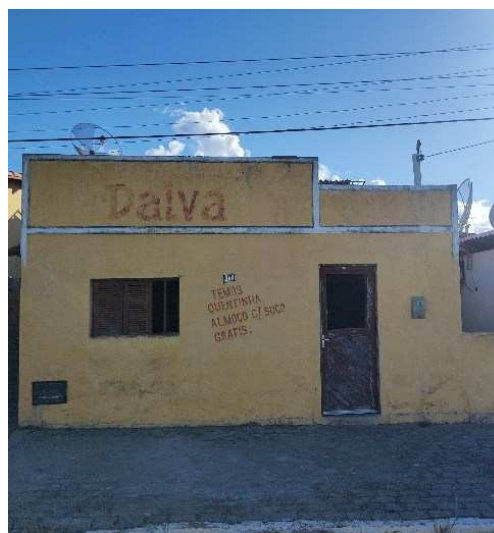
Figura 39 – Residência 168, Rua Vicente Germano
