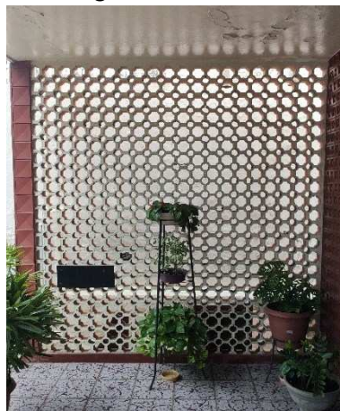
Figura 60 – Parede em cobogó na Residência 163, Avenida Pedro Matos
