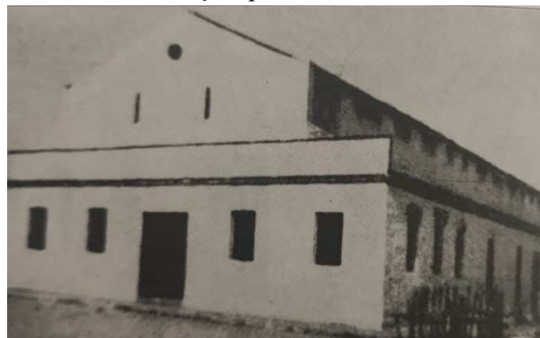
Figura 07 – Mercado Público em processo de construção, por volta de 1930
