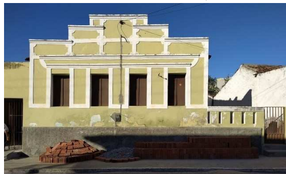
Figura 45 – Fachada da Residência 18, Rua Pedro Moura de Vasconcelos, em 2020
