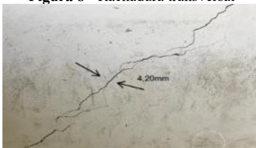
Figura 8 - Rachadura transversal
