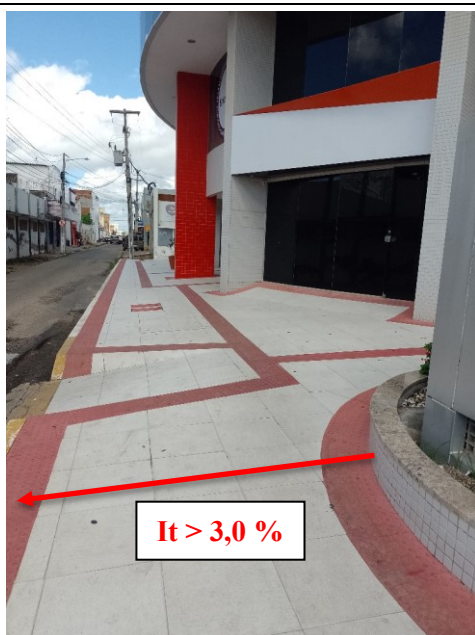
Foto 11 – Inclinação transversal acima da permitida
