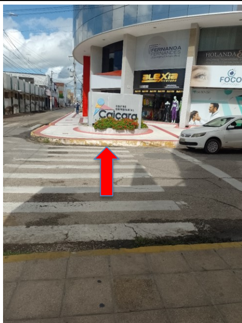
Foto 09 – Ausência de rebaixamento de calçada
