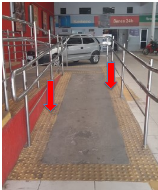
Foto 16 – Piso tátil aplicado de forma irregular
