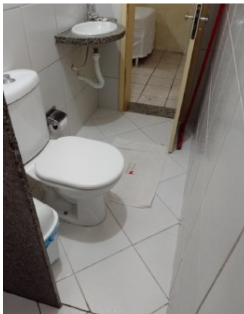
Foto 29 – Banheiro sem características acessíveis
