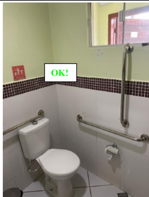
Foto 36 – Sanitário e barras de apoio consoantes a norma
