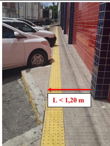
Foto 06 – Largura do passeio inadequada
