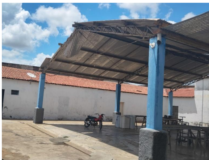
Figura 21- cobertura do Pátio interno
