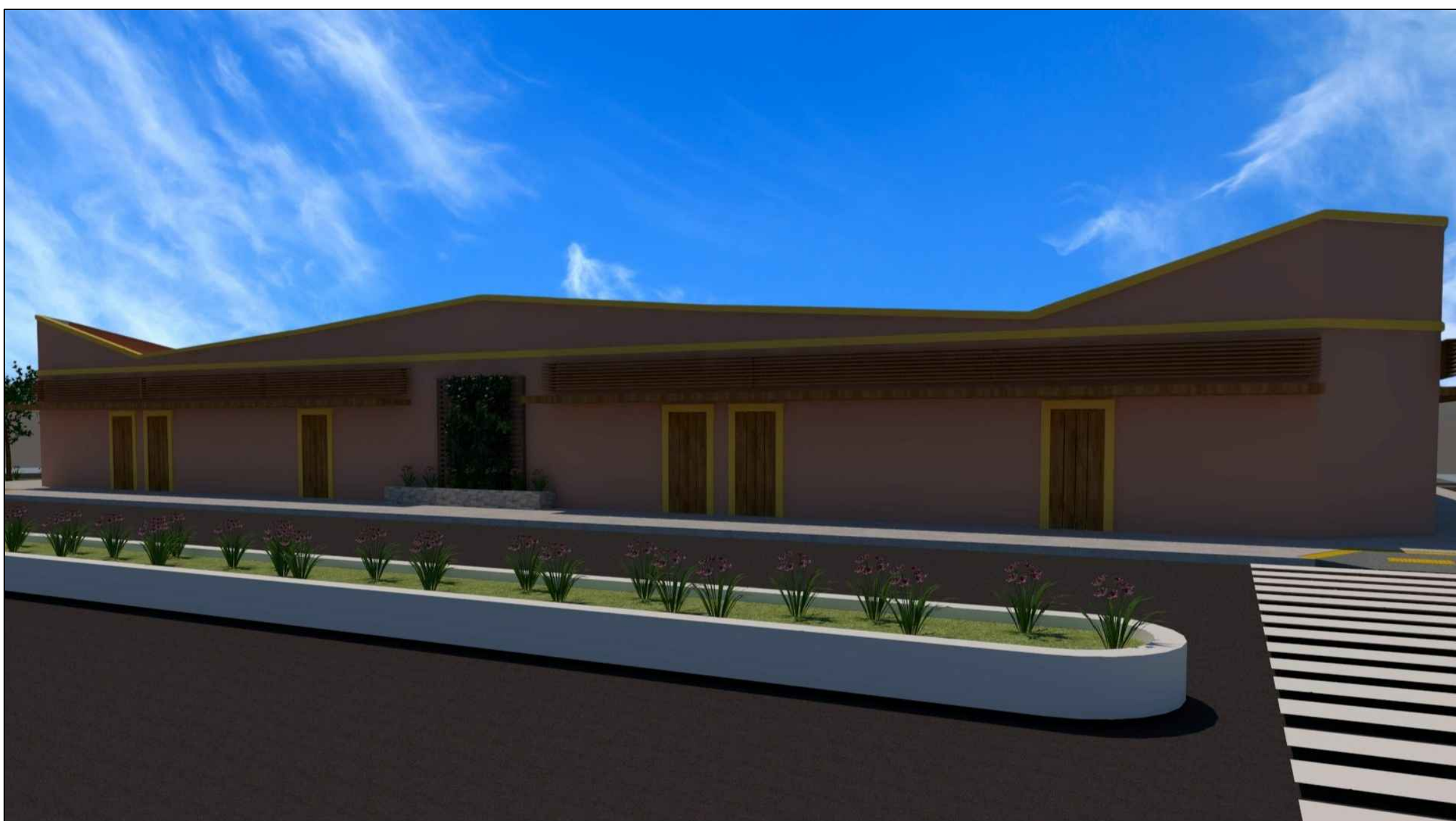
FACHADA LATERAL DIREITA
