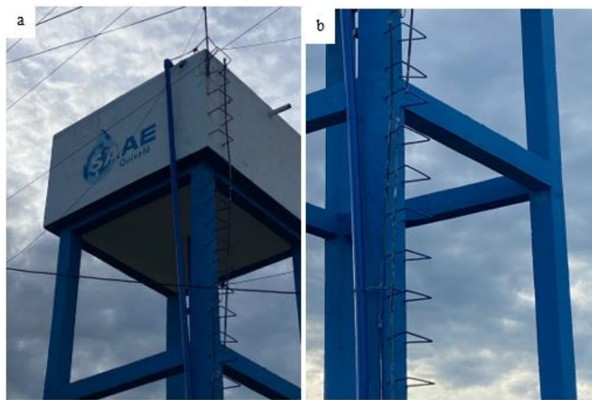
Figura 18 – Pintura do reservatório na parte superior (a) e inferior (b)
