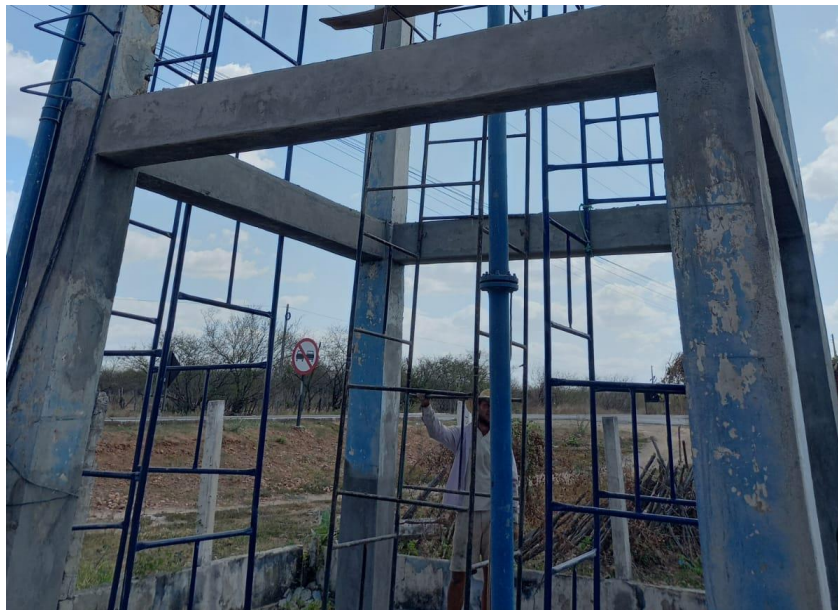
Figura 17 – Aplicação da argamassa para reforço estrutural
