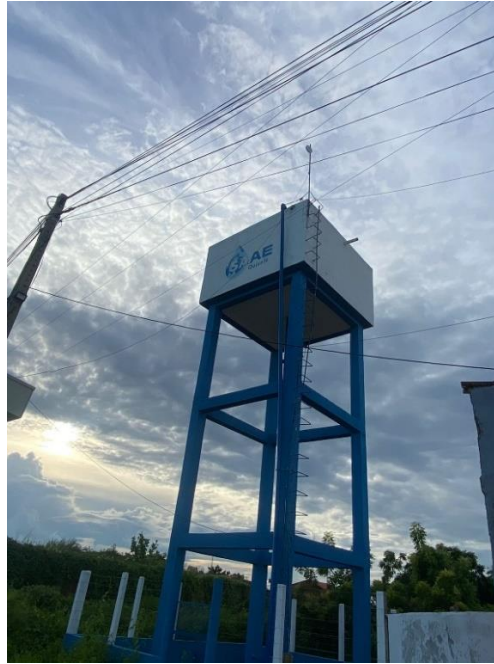
Figura 19 - Reservatório pronto, após as correções das manifestações patológicas
