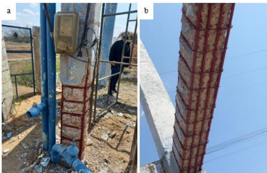
Figura 15 – Aplicação do inibidor de corrosão nas armaduras de pilares (a) e vigas (b)
