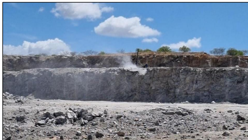
Figura 6: Perfuração rochosa para atividade explosiva.
