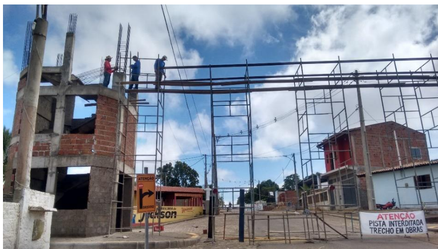
Figura 28: Trabalhadores utilizando andaimes do tipo simplesmente apoiado.
