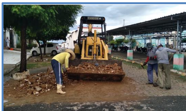
Figura 2 – Limpeza de vias públicas e coleta de resíduos de construção e demolição
