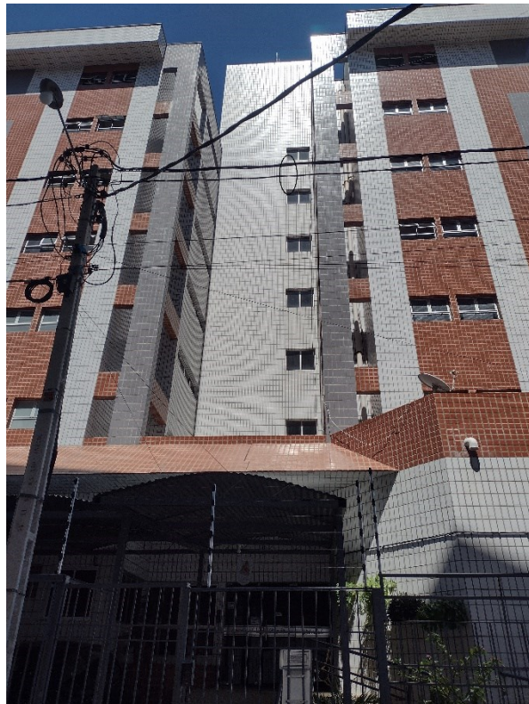
Figura 19 – Segunda imagem da fachada principal do Edifício Liberdade
