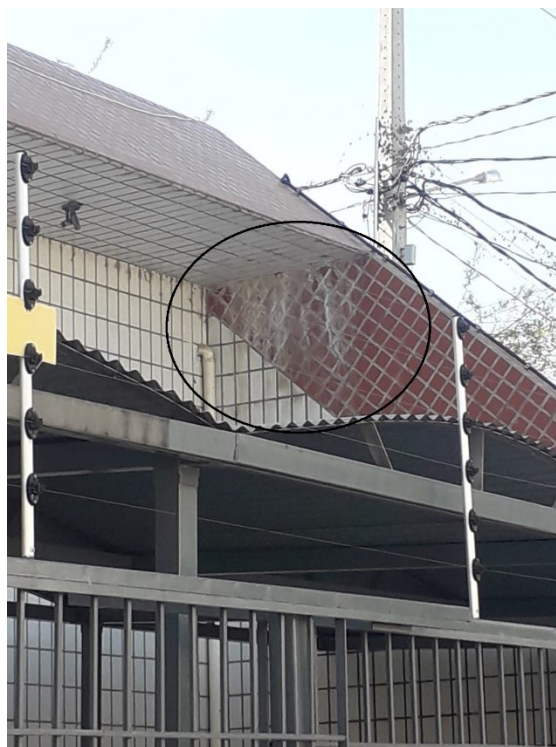
Figura 23 – Imagem da fachada lateral A do Edifício Liberdade
