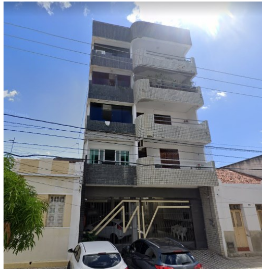
Figura 10 – Fachada principal da Edificação familiar
