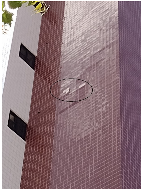
Figura 30 – Imagem da fachada lateral A do Condomínio Varandas do Seridó
