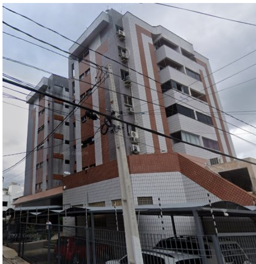
Figura 6 – Fachada do setor residencial do Edifício Liberdade
