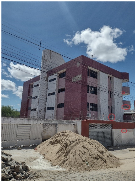
Figura 37 – Imagem global da fachada principal e lateral A do Condomínio Residencial Flor de Cactus
