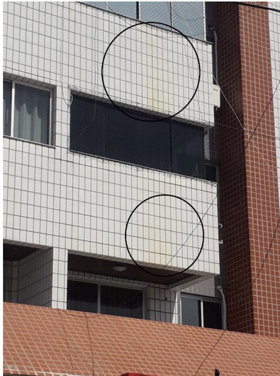
Figura 25 – Segunda Imagem da fachada lateral B do Edifício Liberdade
