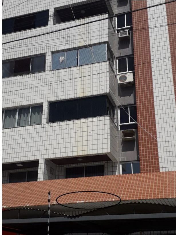
Figura 24 – Primeira imagem da fachada lateral B do Edifício Liberdade
