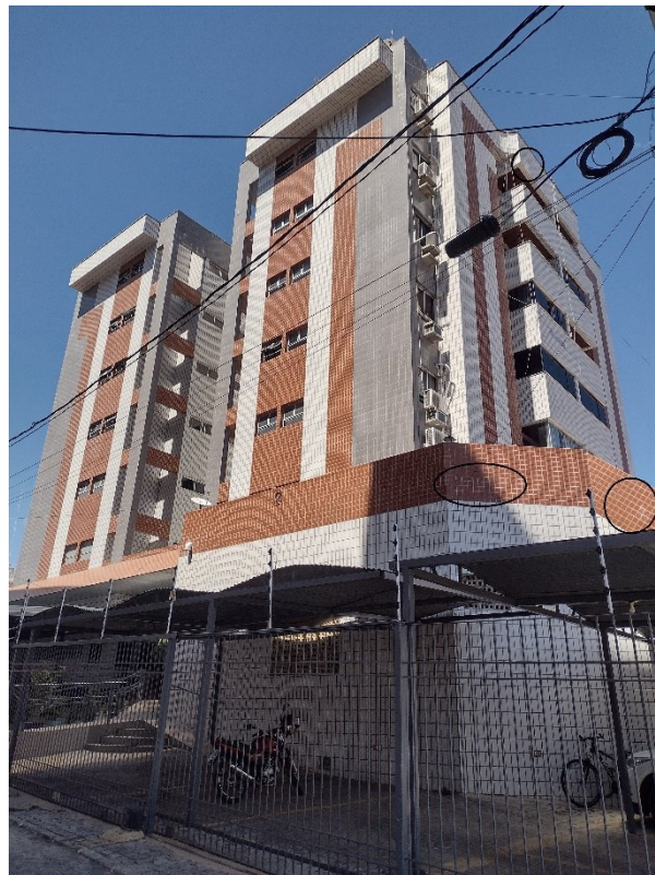
Figura 21 – Imagem global da fachada principal do Edifício Liberdade
