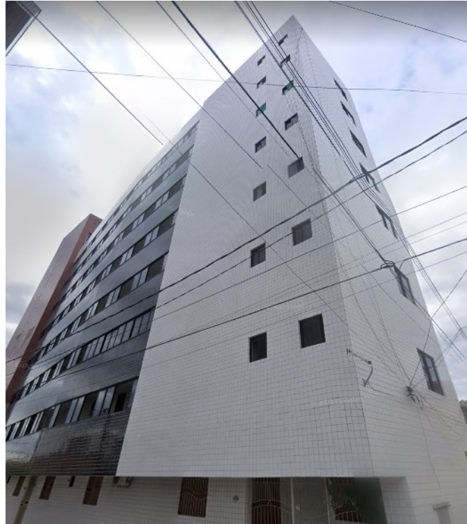
Figura 31 – Imagem da fachada lateral B do Condomínio Varandas do Seridó
