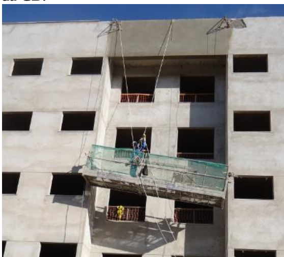
Figura 26 - Plataforma desnivelada na obra da CB.
