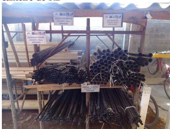
Figura 13 - Existem etiquetas com nomes de materiais e equipamentos por todo canteiro do R2
