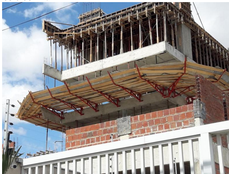
Figura 24 - Plataforma de proteção (bandeja) principal na obra do R1.
