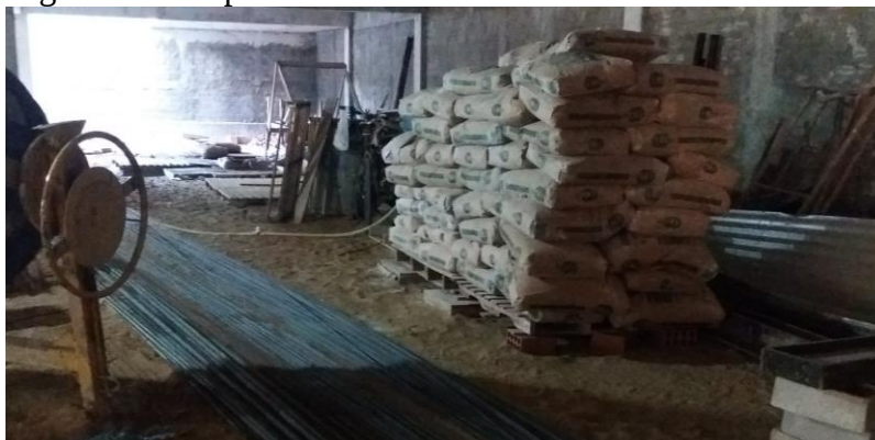
Figura 12 - Empilhamento de Sacos de Cimento no R1.
