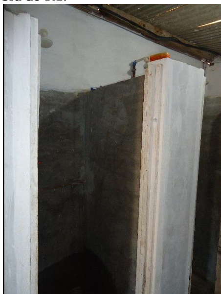
Figura 28 - Banheiro/Lavatório da obra do R1.
