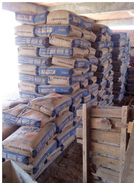
Figura 11 - Empilhamento de Sacos de Cimento no R3.
