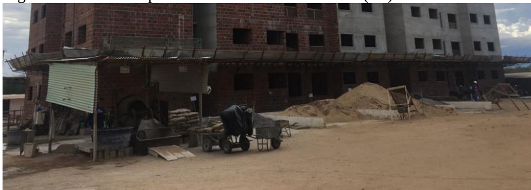
Figura 19 - Betoneira próxima as baias de areia e brita (R2).
