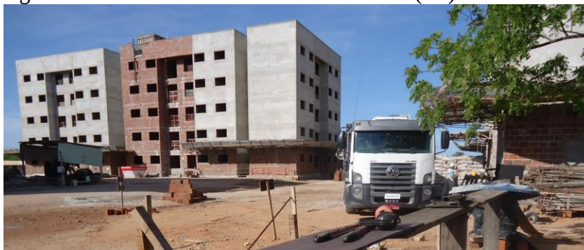
Figura 21 - Entrada de caminhões no canteiro (R2).
