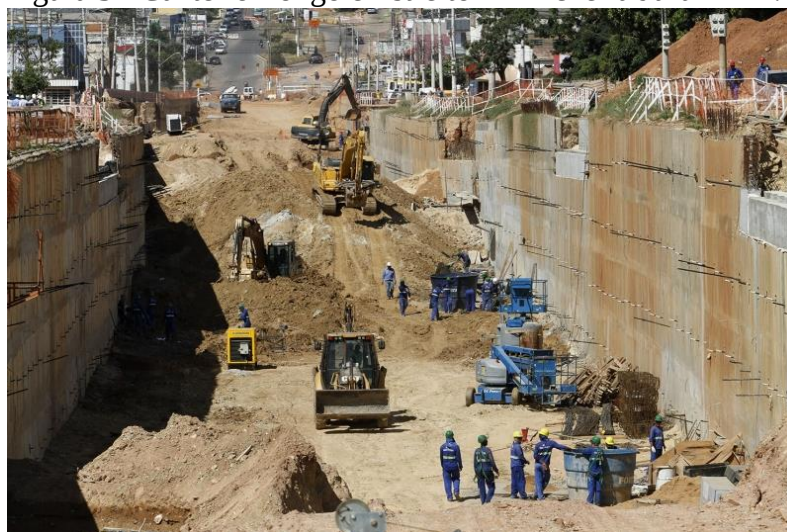
Figura 3 - Canteiro Longo e Estreito - Trincheira Jurumirim.
