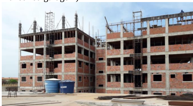
Figura 9 - Estágio Atual do Residencial 3 (Vista do 1º andar da garagem)
