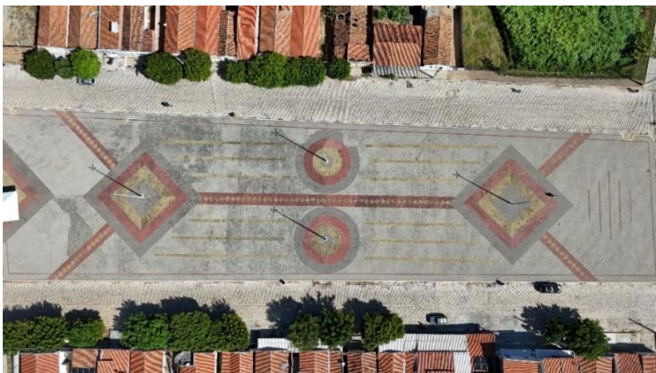
Figura 57 - Vista superior da Praça de Eventos Mãe Preta
