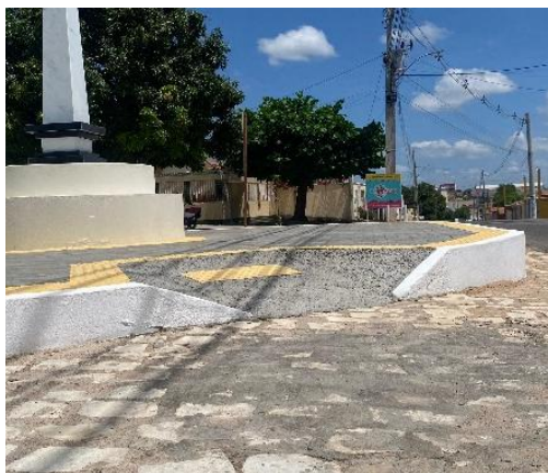
Figura 17 - Rampa de acessibilidade da praça Aguielo Gurgel
