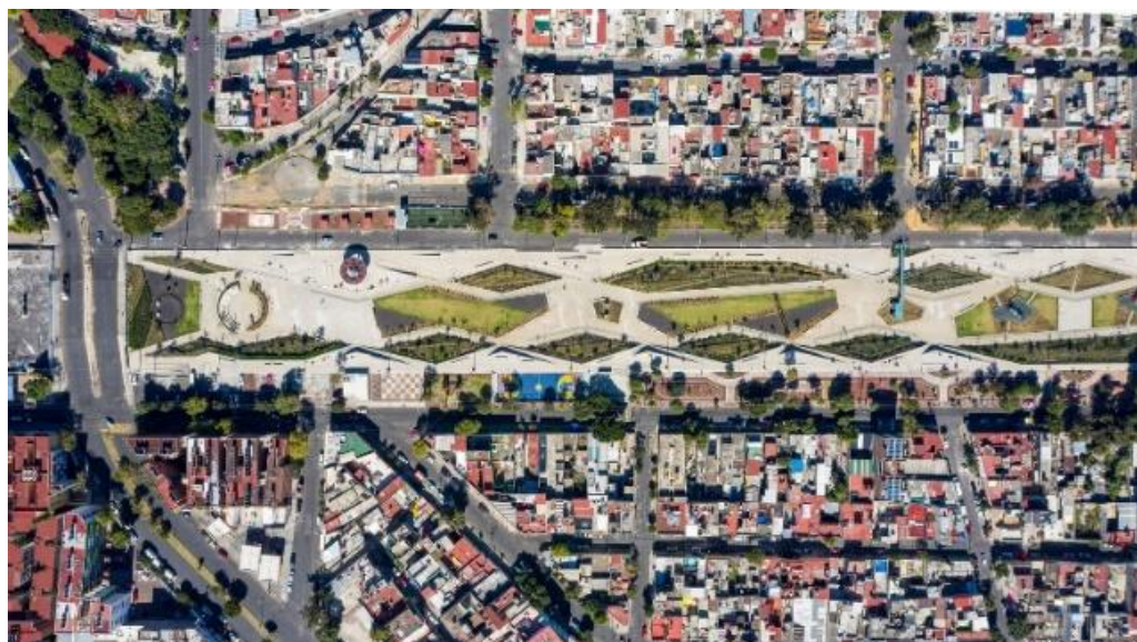
Figura 29 - Vista superior do parque
