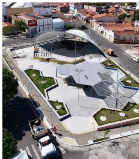
Figura 16 - Vista aérea da praça da biblioteca Francileno de Góis
