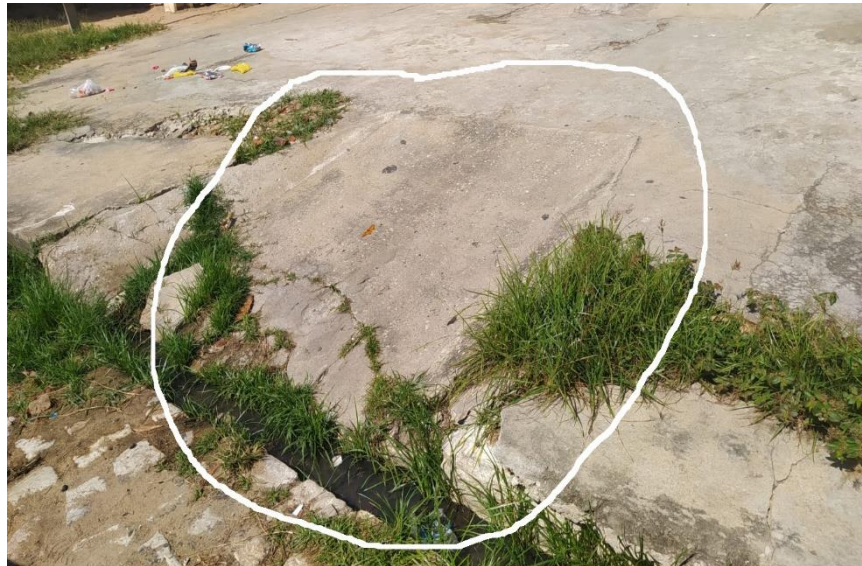
Figura 10 – Rampa que dá acesso à escola.
