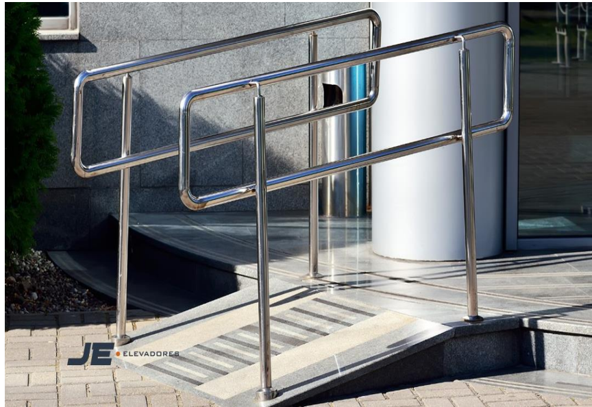
Figura 02 – Rampa de acessibilidade.
