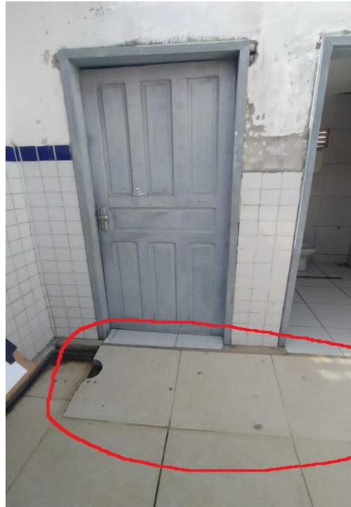
Figura 21 – Rampa dos banheiros infantis da Escola Flor do Deserto.
