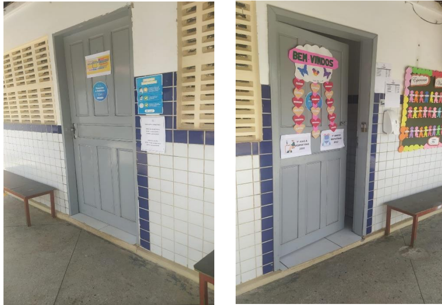
Figuras 26a e 26b – Desnível das salas de aula – Escola Doutora Rosa.
