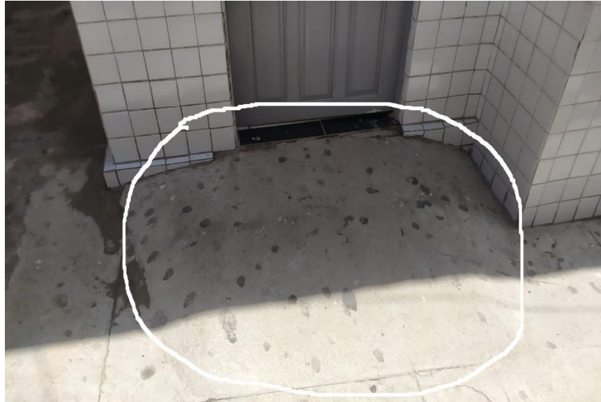
Figura 14 – Rampa de acesso ao banheiro dos professores.
