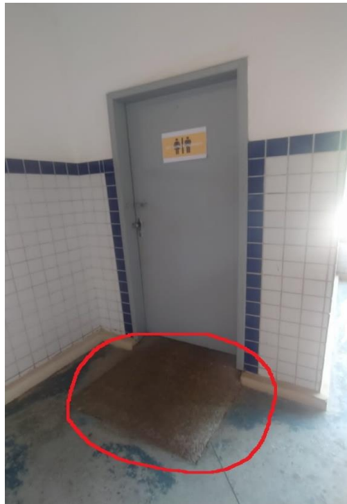
Figura 28 – Rampa do banheiro dos funcionários - Escola Doutora Rosa.
