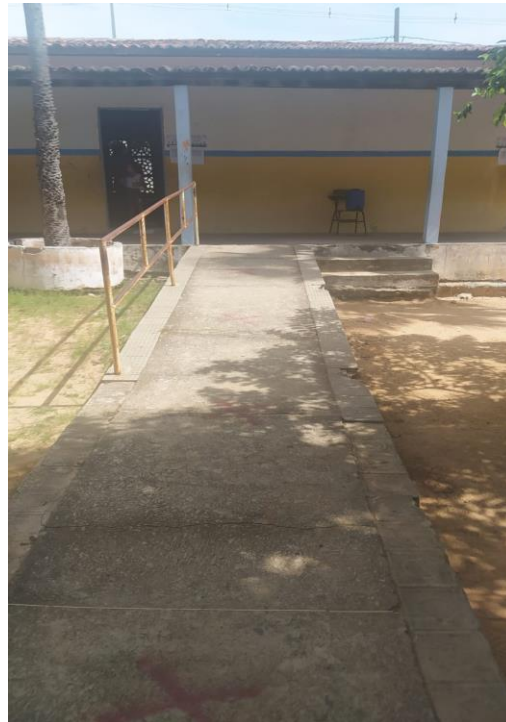
Figura 31 – Calçada do Bloco 1 – Escola Municipal Tulipas.
