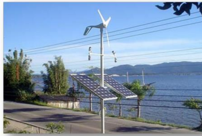
Figura 8 – Sistema híbrido eólico fotovoltaico.
