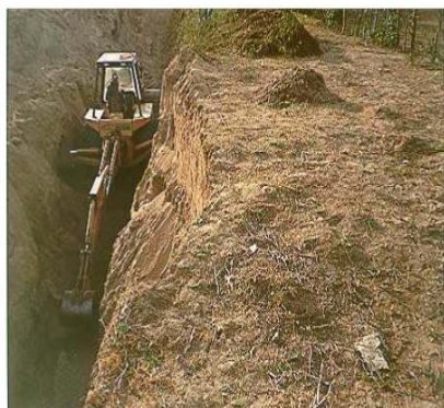
Figura 4 - Abertura da vala à esquerda e a colocação da lona para o barramento
