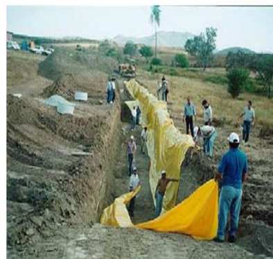
Figura 4 - Abertura da vala à esquerda e a colocação da lona para o barramento
