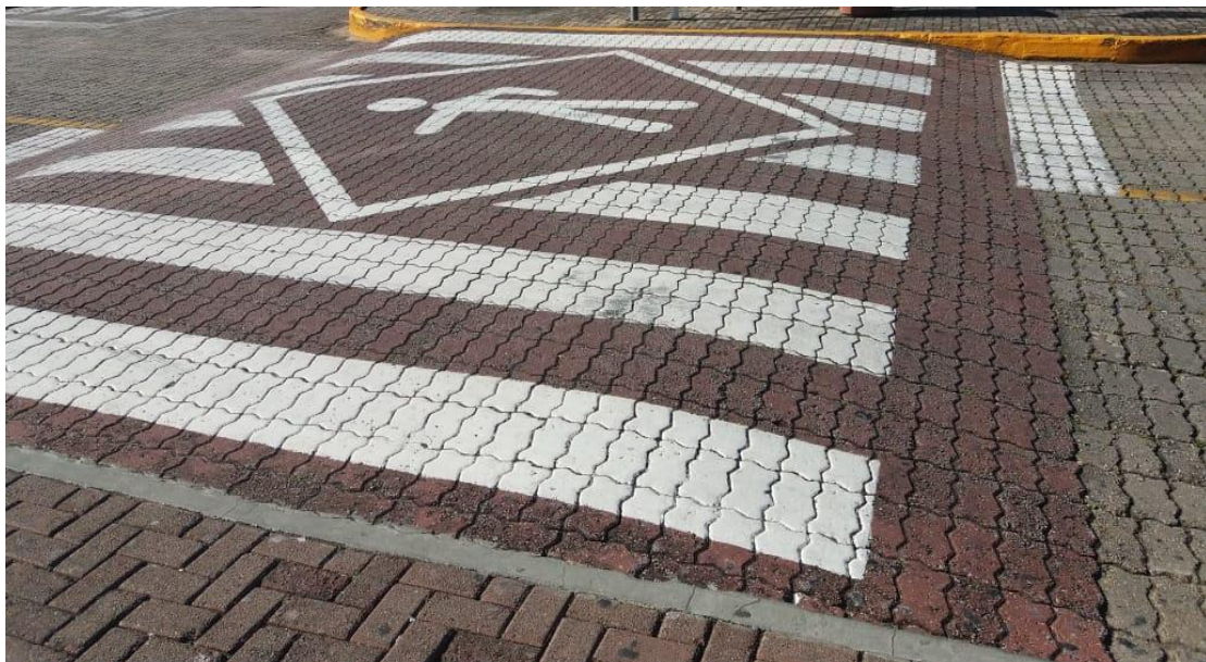
Figura 5– Faixa elevada feitas com blocos intertravados de 16 faces para o acesso ao estacionamento do Shopping Iguatemi em Fortaleza-CE.
