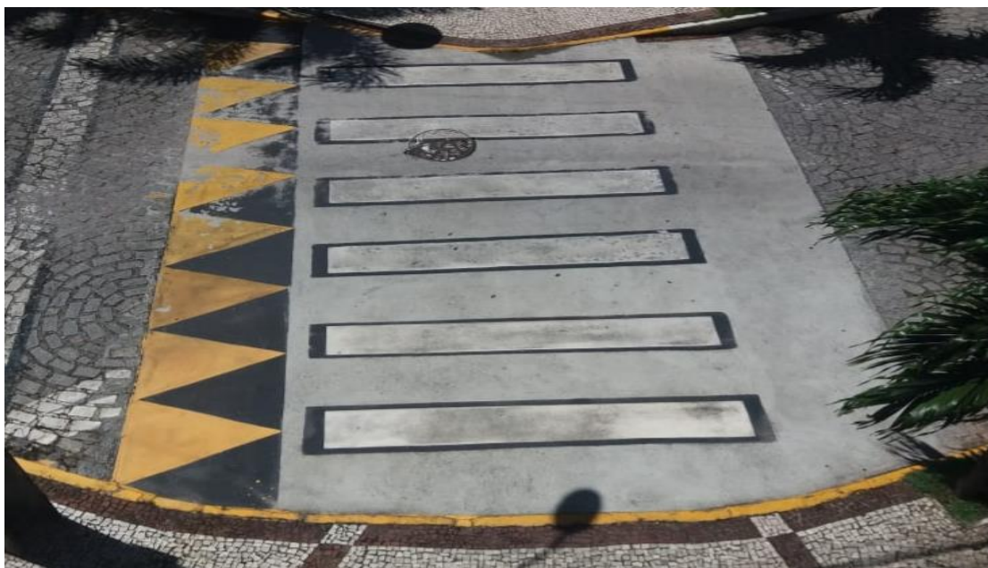
Figura 7– Faixa elevada composta com concreto em Fortaleza-CE.
