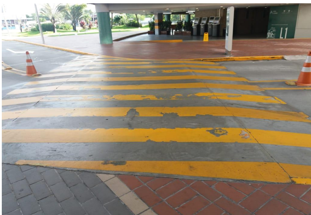
Figura 8- Faixa elevada constituída com concreto no Shopping Iguatemi em Fortaleza-CE.
