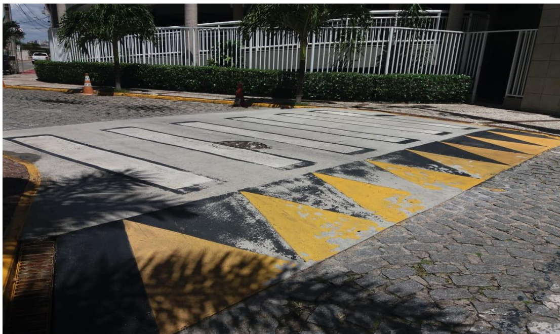
Figura 6– Faixa elevada composta com concreto em Fortaleza-CE.
