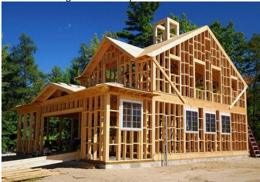
Figura 2: Construção em Wood Frame
