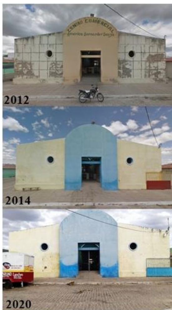
Figura 7. Fachada Frontal do Mercado Público ao longo dos últimos 8 anos.
