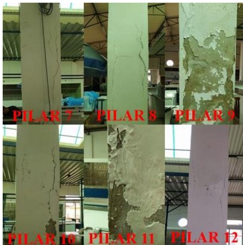
Figura 13. Pilares fissurados e com umidade por capilaridade.
