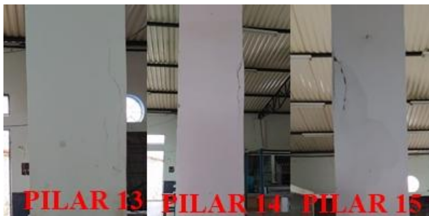
Figura 13. Pilares fissurados e com umidade por capilaridade.
