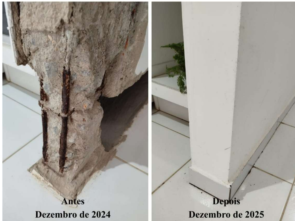
Figura 45 - Pilar antes e depois do tratamento.
