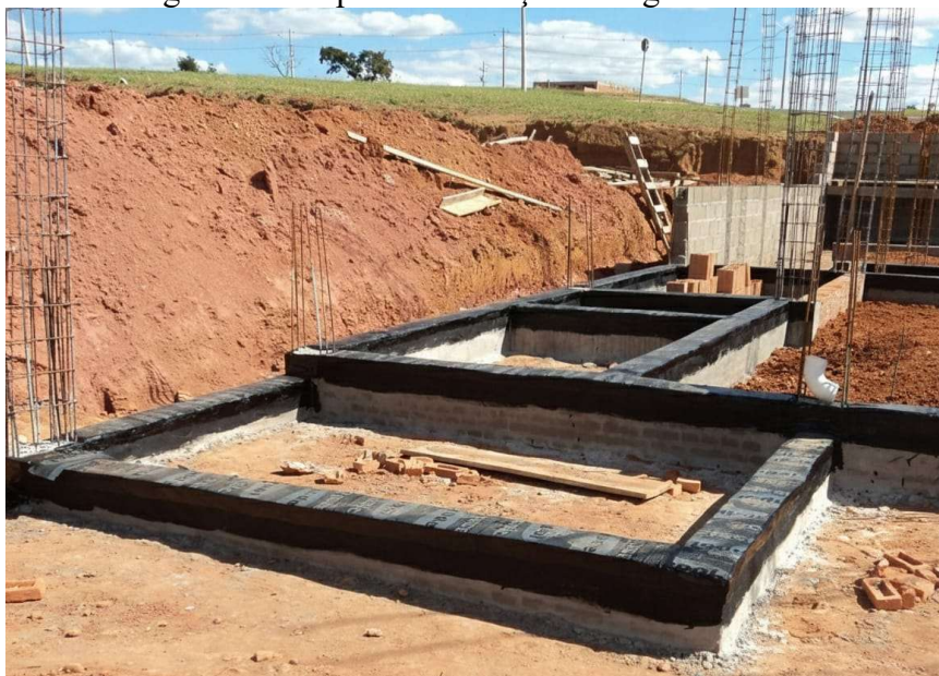
Figura 11 - Impermeabilização da viga baldrame.
