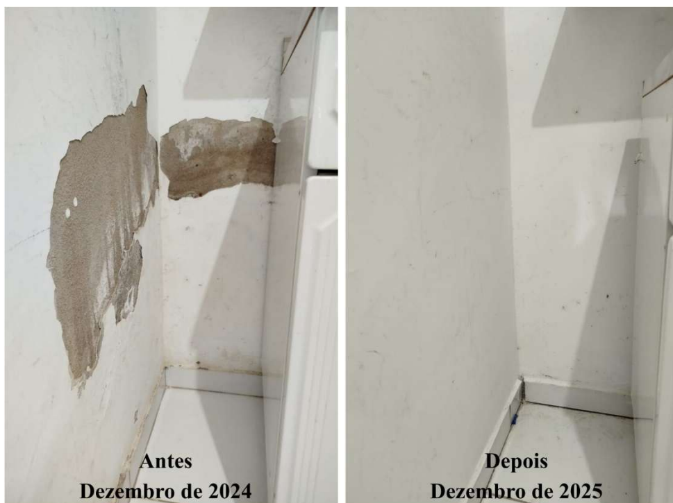
Figura 44 - Parede interna antes e depois do tratamento.
