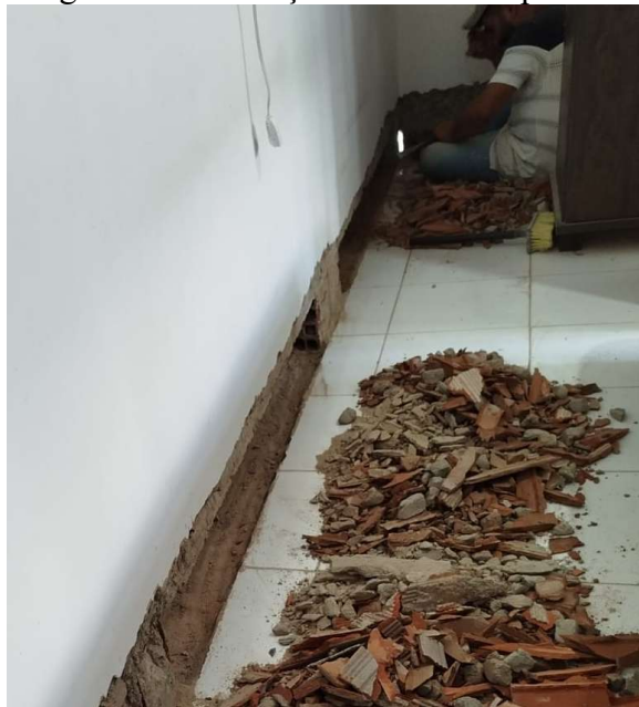
Figura 33 - Execução de cortes na parede.
