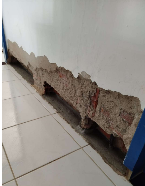
Figura 39 - Área cortada com material impermeável aplicado.
