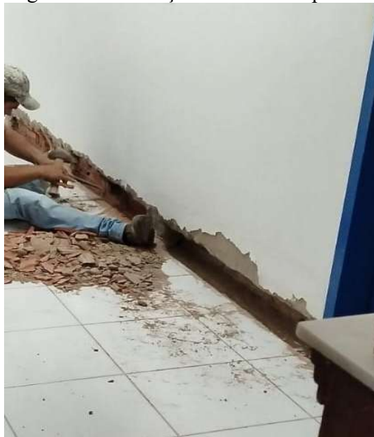
Figura 34 - Execução de cortes na parede.
