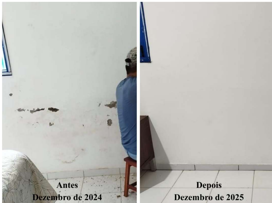
Figura 43 - Parede interna antes e depois do tratamento.
