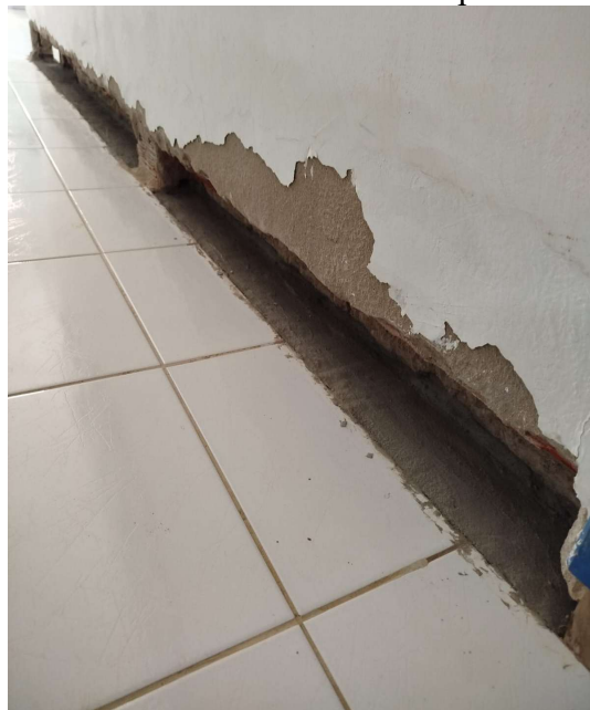
Figura 38 - Área cortada com material impermeável aplicado.
