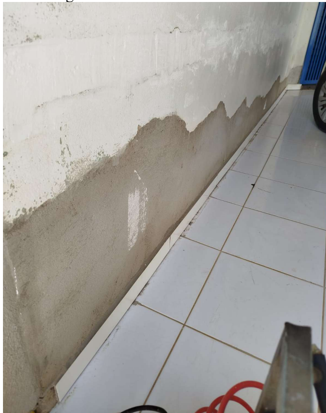
Figura 41 - Novo reboco construído.
