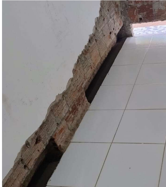
Figura 37 - Área cortada com material impermeável aplicado.
