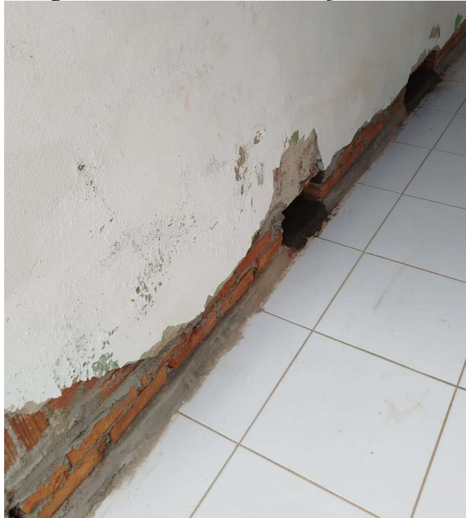
Figura 40 - Preenchimento com tijolos cozidos.
