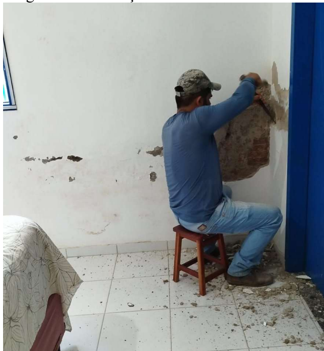
Figura 32 - Remoção do revestimento afetado.
