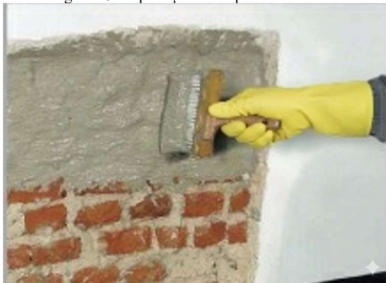
Figura 13 - Aplicação do impermeabilizante.
