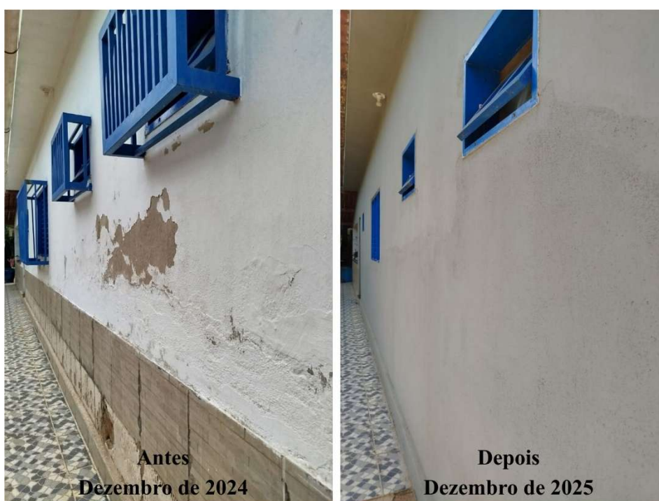
Figura 42 - Parede externa antes e depois do tratamento.
