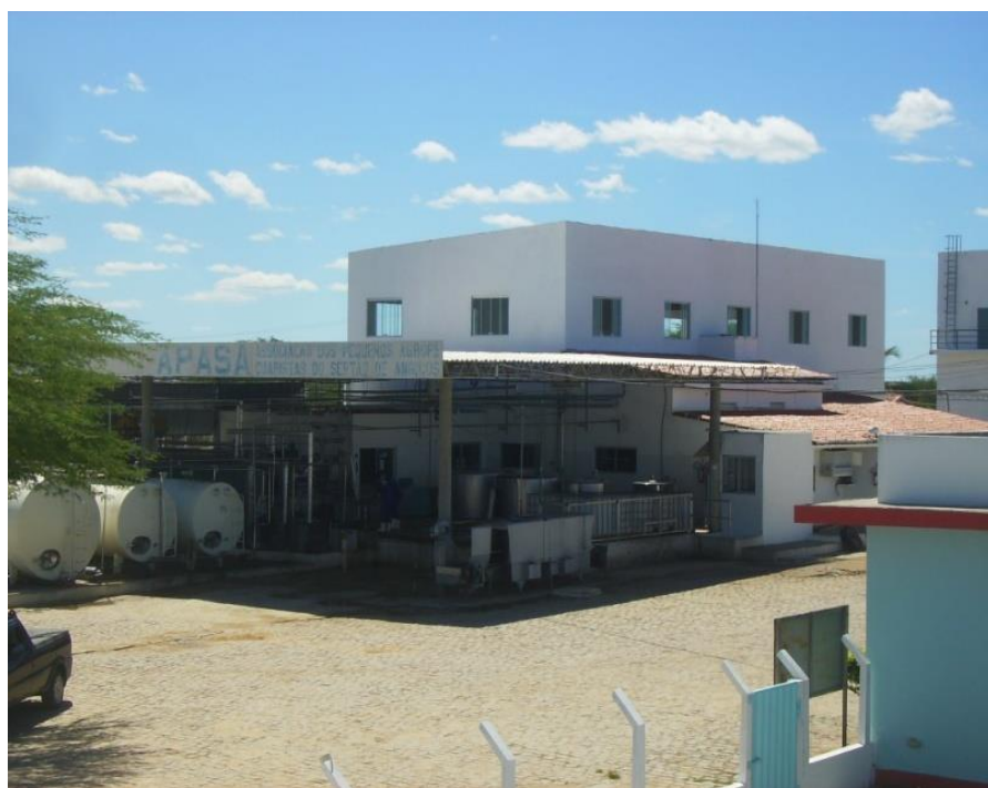
Figura 1. Instalações da APASA.
