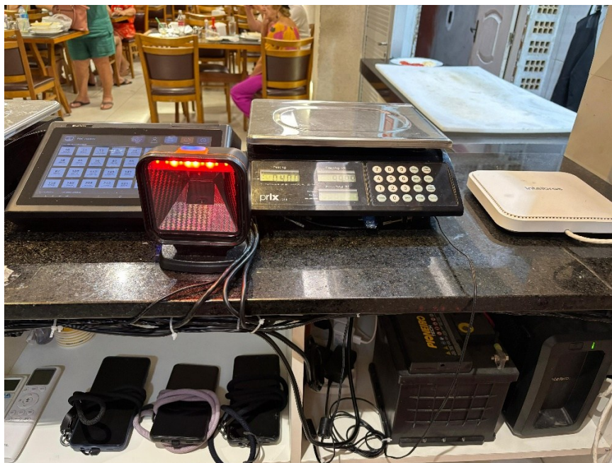
Figura 7 – Estação de venda com infraestrutura de TI e energia.
