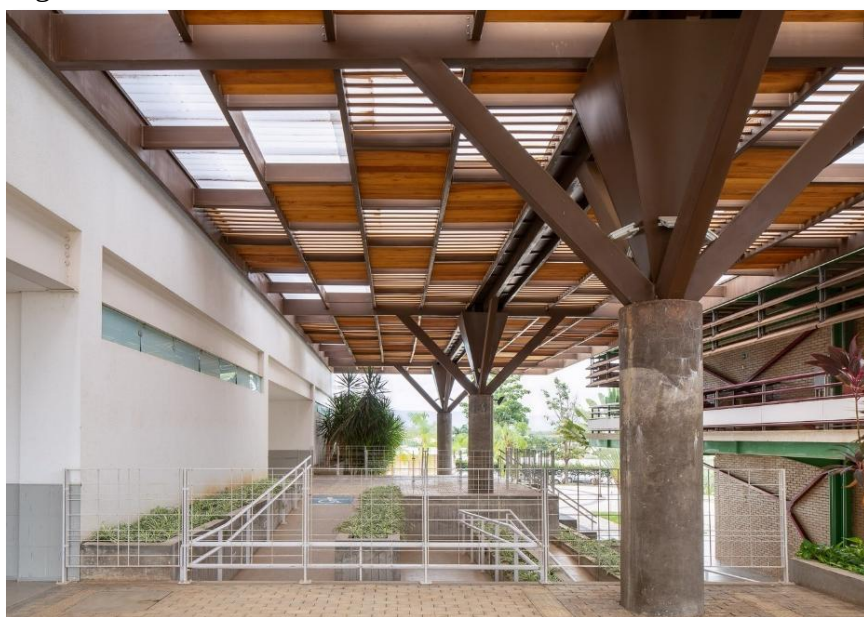
Figura 55 - Pavilhões educacionais Unileão.
