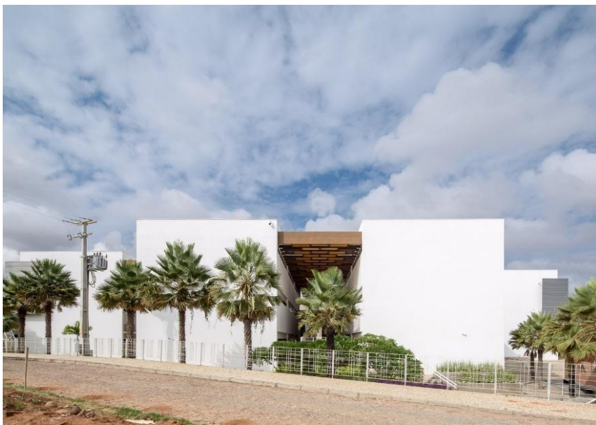
Figura 54 - Pavilhões educacionais Unileão.
