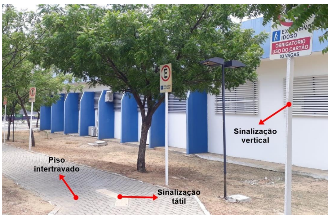
Figura 21 - Acesso pela fachada oeste da Biblioteca.
