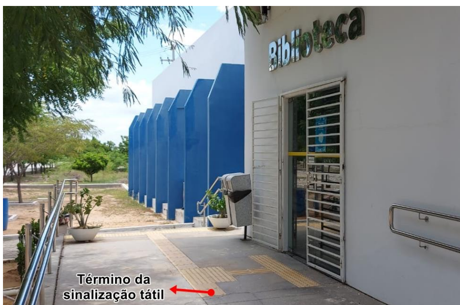
Figura 27 - Sinalização tátil termina antes da rampa.
