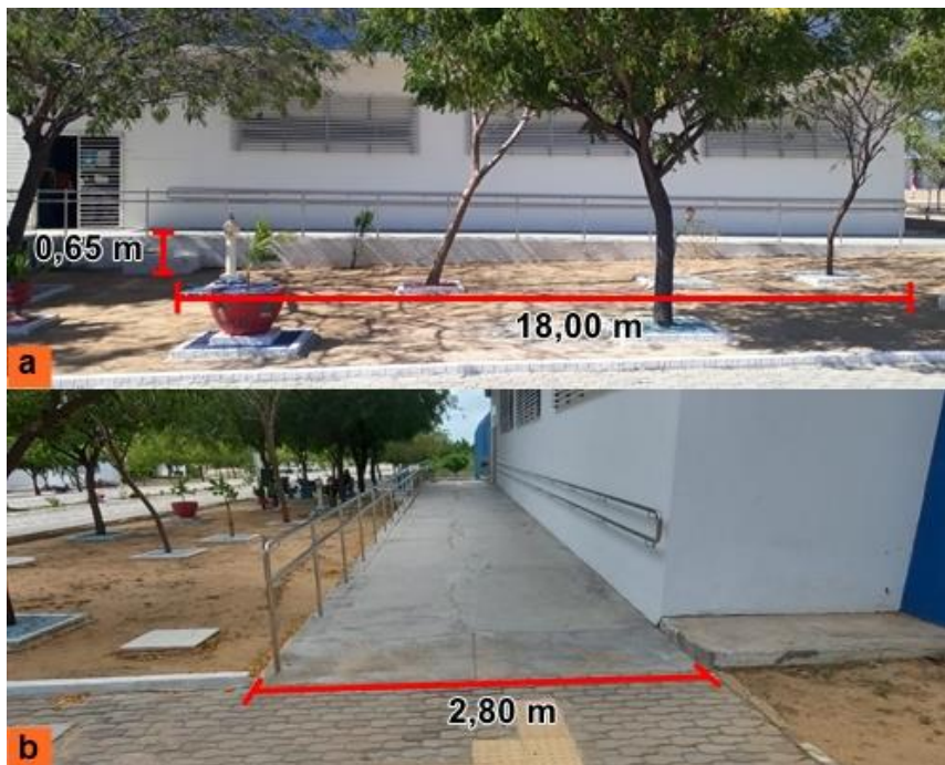
Figura 23 - Rampa de acesso a Biblioteca e suas respectivas medidas: a) vista lateral e b) vista frontal.
