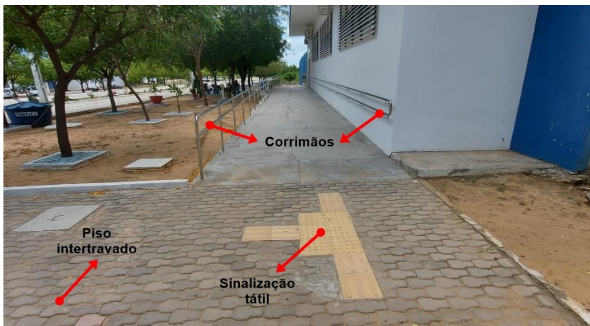
Figura 22 - Vista lateral da fachada frontal da Biblioteca.
