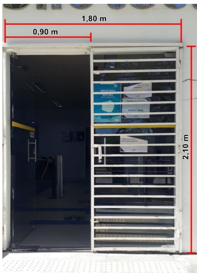
Figura 25 - Porta de acesso principal da Biblioteca Campus Angicos.
