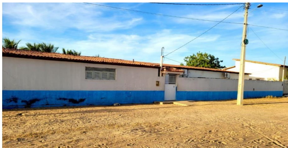
Figura 1 – Fachada da Escola.
