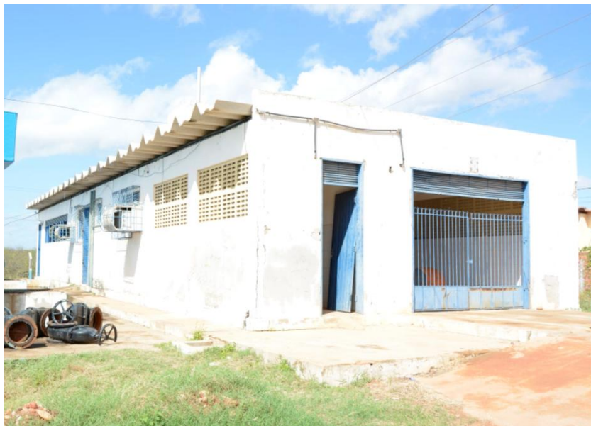
Figura 8 - Laboratório de análises de água
