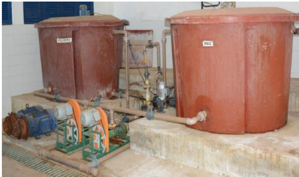
Figura 4 - Bomba dosadora de PAC
