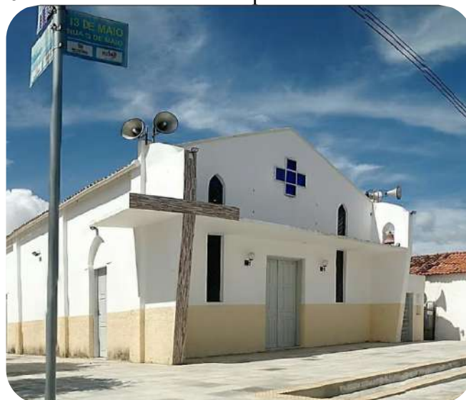
Figura 46 - Primeira fachada da Capela de Nossa Senhora de Fátima
