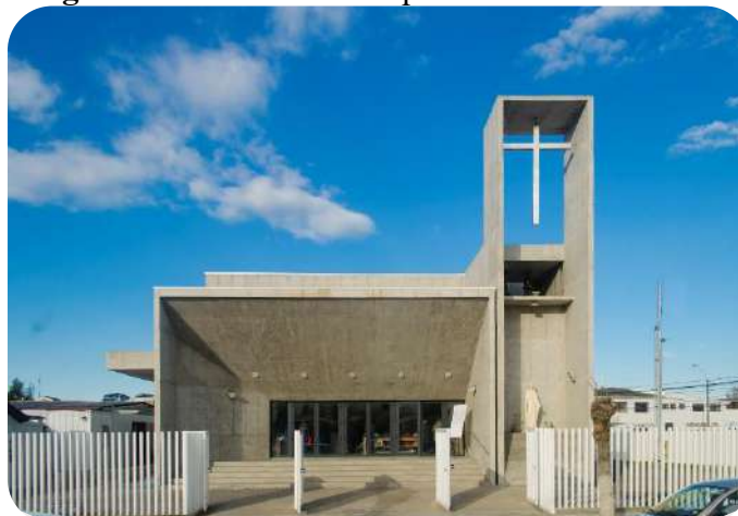
Figura 49 - Fachada Paróquia Todos Los Santos.
