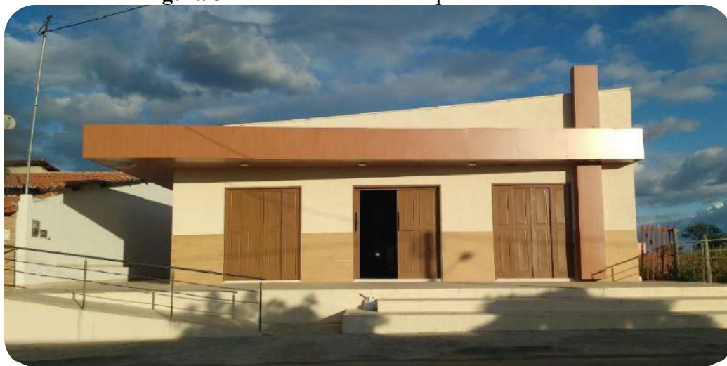
Figura 52 - Atual fachada da Capela de Santo Antônio.
