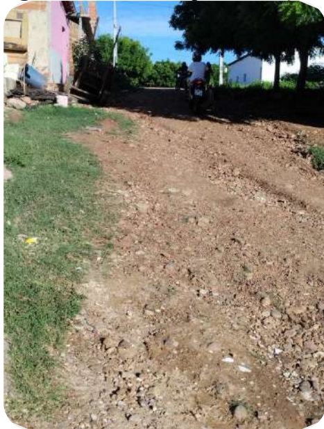
Figura 75 - Rua sem pavimentação
