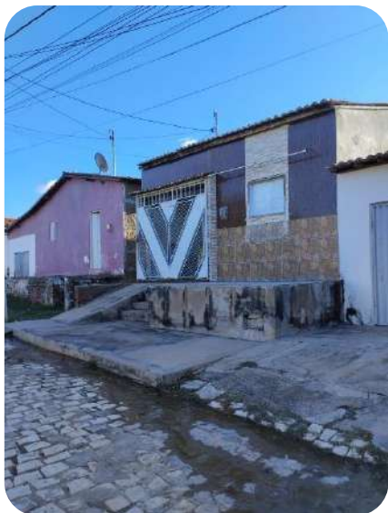
Figura 70 - Edificação bairro Manoel Deodato.
