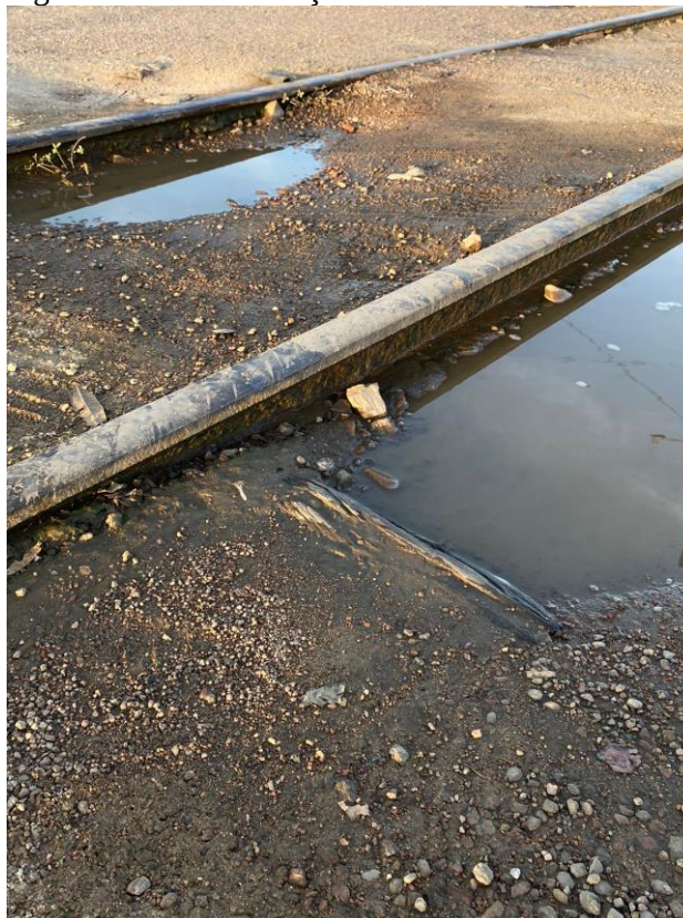
Figura 12: Trilhos Estação Ferroviária de Sousa - PB
