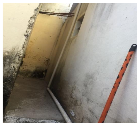
Figura 29: Tubulação exposta
