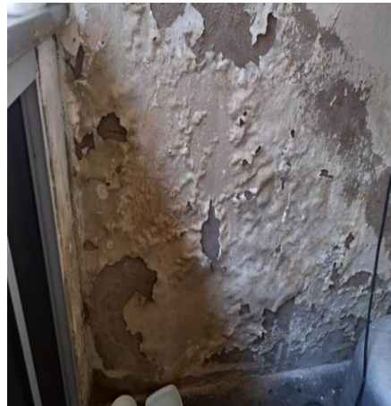
Figura 10: Rompimento da tubulação
