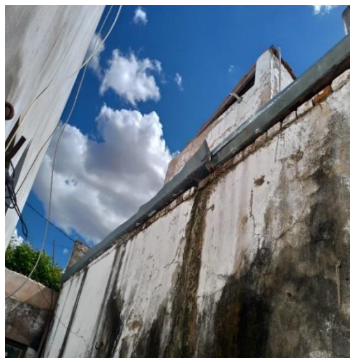
Figura 15: Fixação da calha
