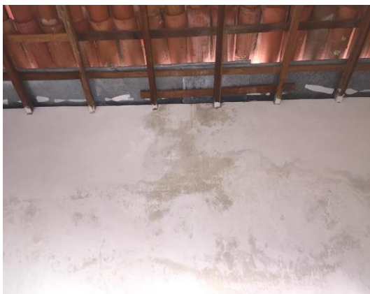
Figura 20: Fixação da calha
