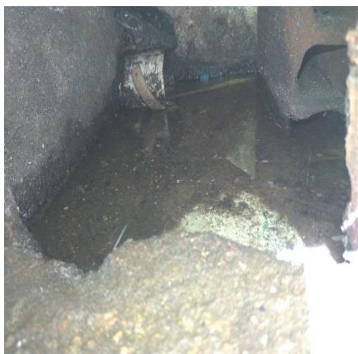
Figura 14: Tubulações da caixa de gordura exposta
