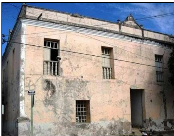
Figura 8: Prédio Câmara e Cadeia antes da reforma
