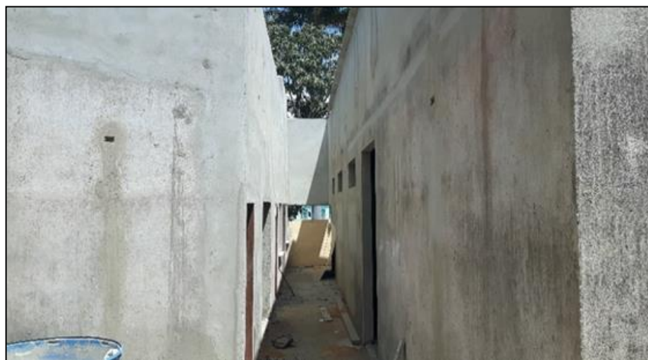
Figura 15: Alvenaria Auditório, Quiosque E Banheiro
