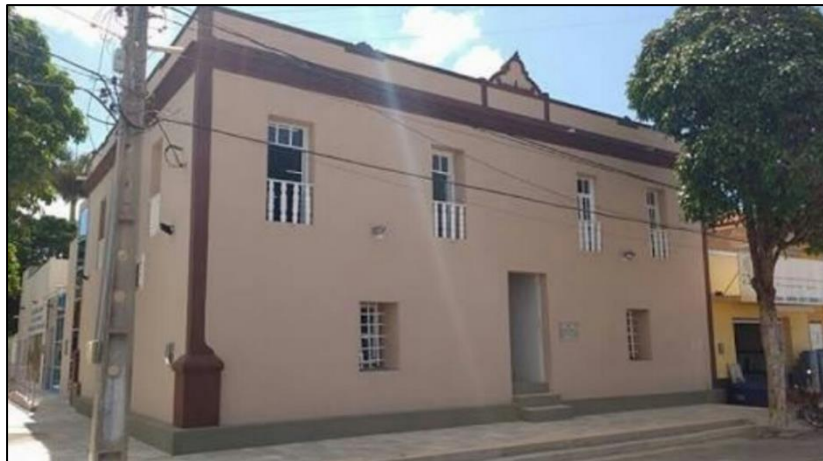
Figura 9: Prédio Câmara e Cadeia antes da reforma
