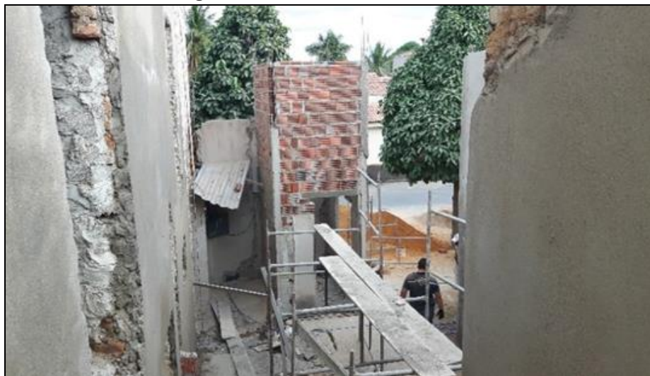
Figura 14: Alvenaria Da Bilheteria
