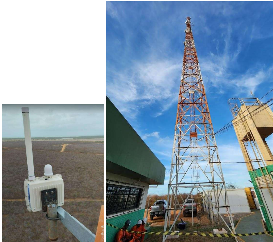
Figura 10 – Torre de antenas. Fonte: Autoria própria.
