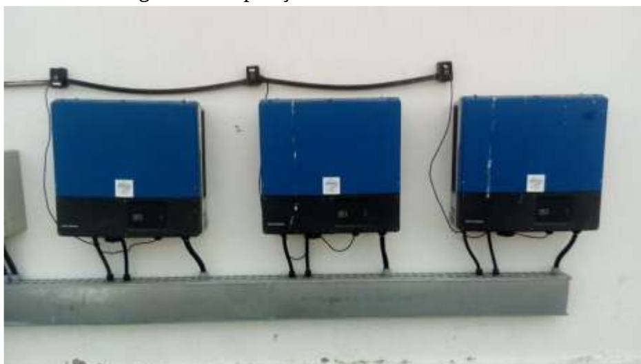
Figura 4 - Disposição estrutural dos inversores
