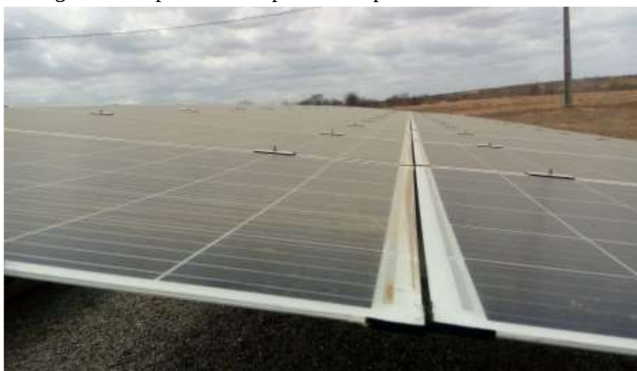
Figura 6 – Superfície com película de poeira dos módulos solares
