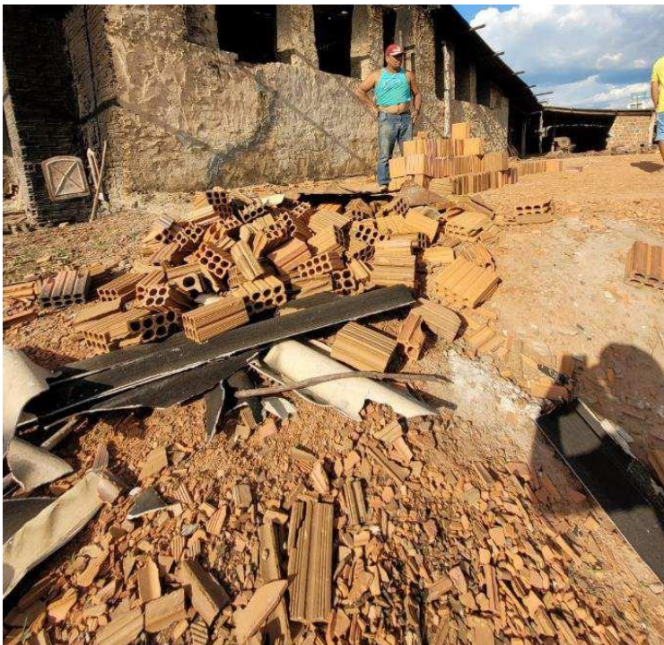
Figura 3: Restos de tijolos na olaria dos Nogueira
