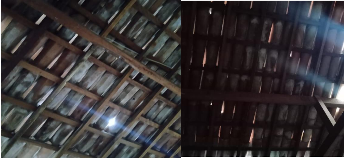
Figura 41: Cobertura dos blocos de aulas, sala 05 e sala 06.
