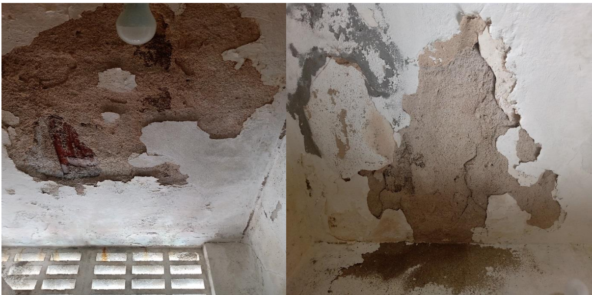
Figura 28: Destacamento do revestimento e infiltrações no banheiro masculino.
