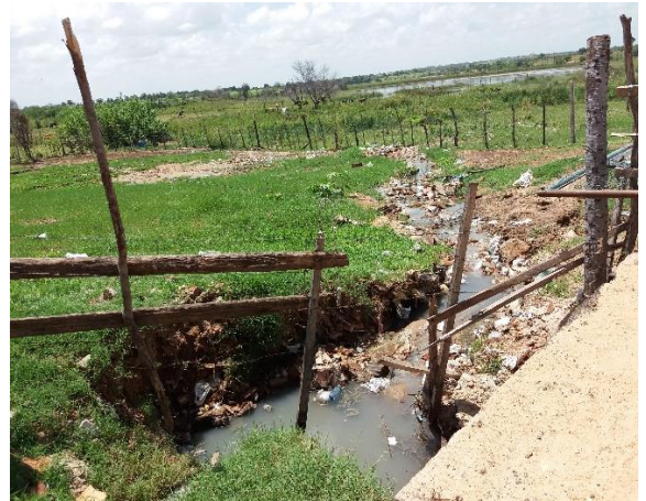
Figura 23 - Despejo de esgoto na lagoa
