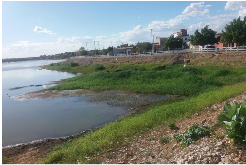
Figura 5 - Forragem as margens da lagoa
