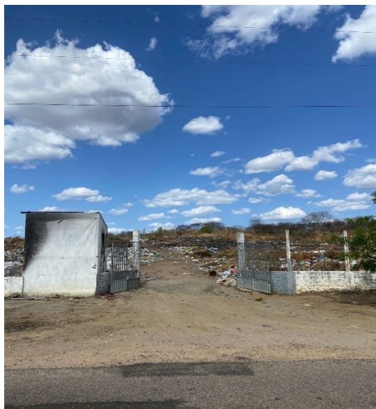
Figura 4 - Estrutura portaria e controle de acesso ao aterro de Antônio Martins/RN
