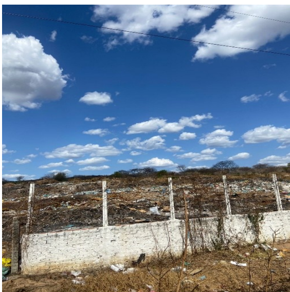
Figura 5 - Estrutura de contenção e isolamento do aterro controlado de Antônio Martins/RN
