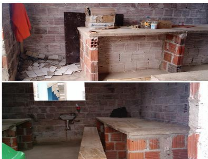
Figura 11: Refeitório (1ª Visita)
