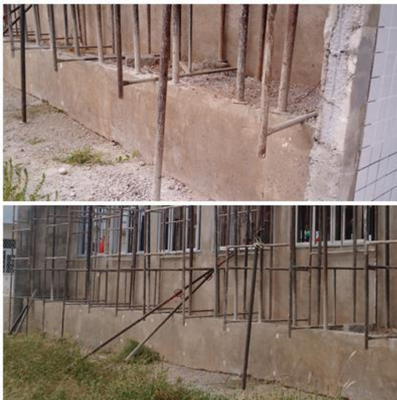
Figura 20: Superfície de apoio do andaime fachadeiro
