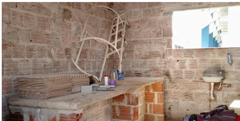
Figura 12: Refeitório (2ª Visita)
