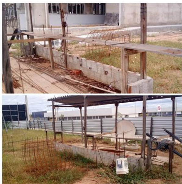
Figura 15: Área de corte e dobragem de vergalhões
