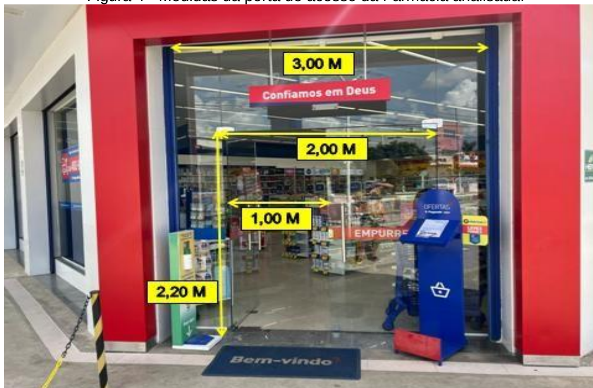
Figura 4 - Medidas da porta de acesso da Farmácia analisada.
