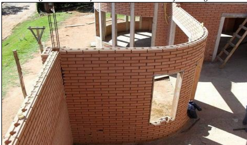
Figura 5 - Construção residencial utilizando tijolo ecológico.
