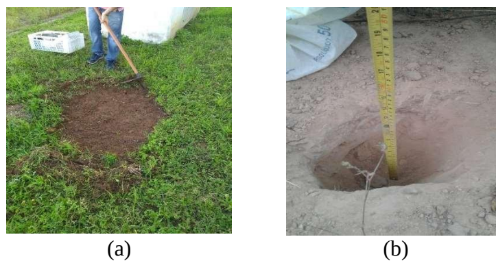
Figura 4 – (a) utilização da enxada para preparação da superfície de escavação; (b) medição da profundidade da cava.
