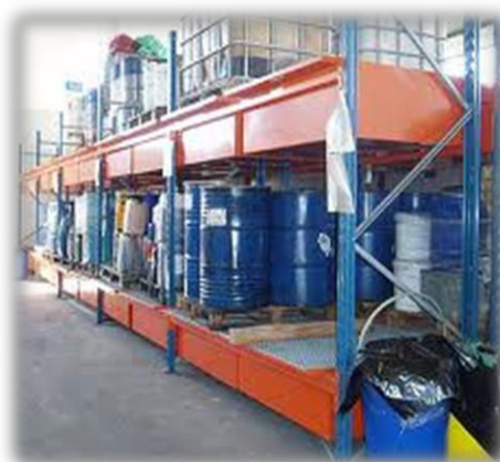
Figura 2.8. Acondicionamento dos resíduos sólidos
