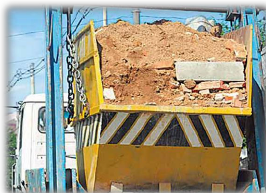
Figura 2.9. Transporte de RCC.
