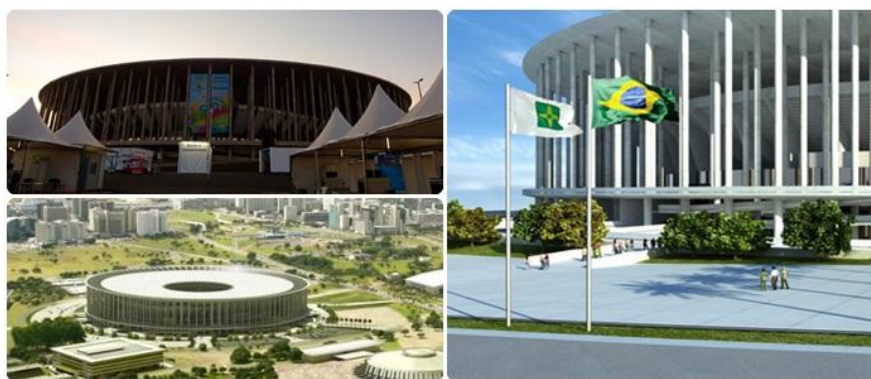
Figura 5.2. Estádio Nacional de Brasília Mané Garrincha
