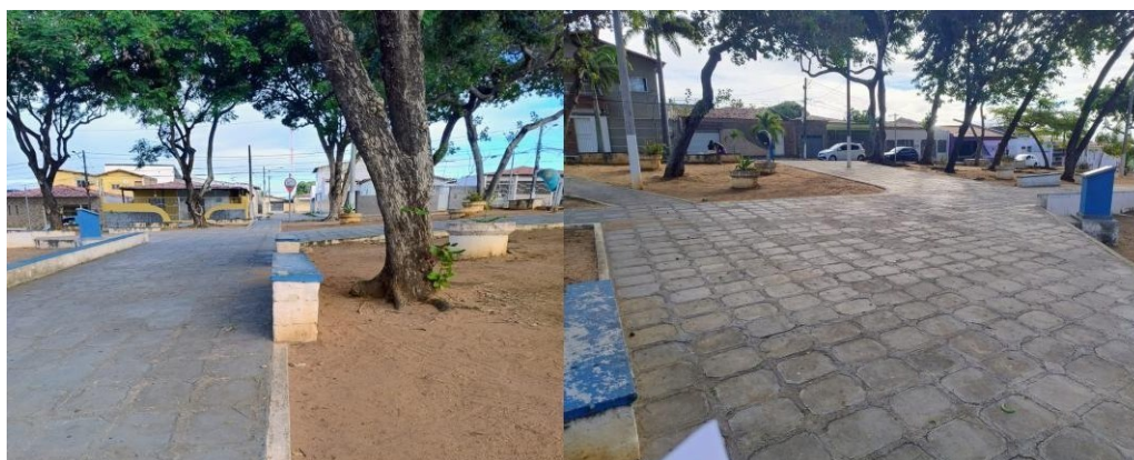
Figura 19 – Ausência de sinalização tátil no piso do local.
