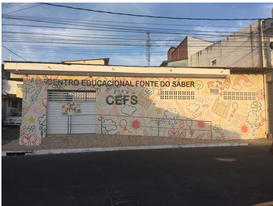
Figura 22: Fachada da escola
