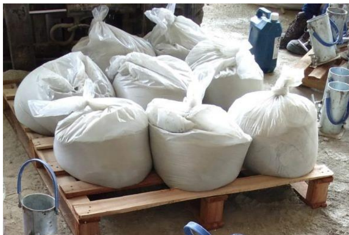
Figura 7: Armazenamento do cimento em sacos plástico.
