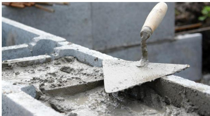
Figura 3: Preenchimento de blocos estruturais com graute.
