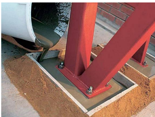
(c) utilização do graute na construção.
