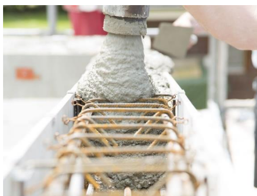
(f) utilização de graute na criação de elementos pré-moldados.
