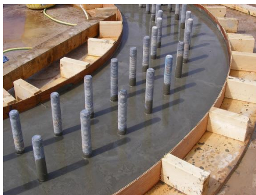
(d) fixação de placas e chumbadores.
