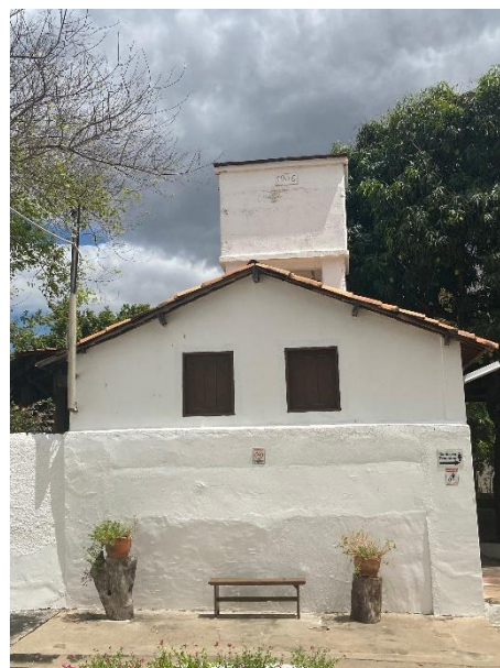
Figura 53: Sala de banho e sanitário isolados no fundo do quintal.
