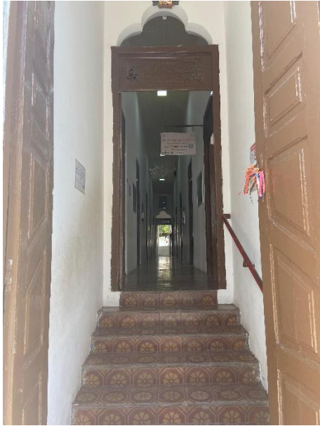
Figura 46: Arco com esquadria de madeira.
