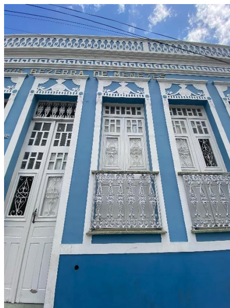
Figura 31: Detalhe da porta e dos arcos.
