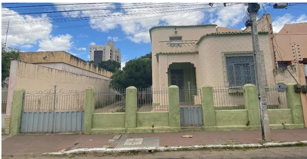
Figura 72: Fachada do Bangalô 436.
