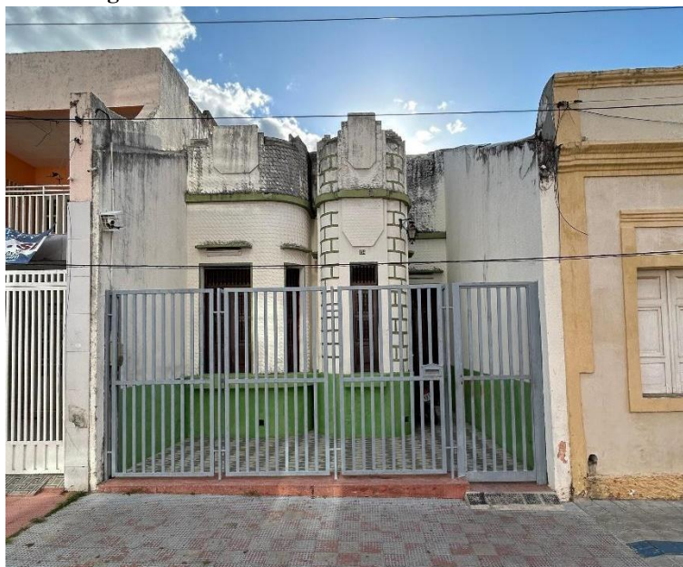
Figura 32: Fachada da casa 134 ou Casa da Arandela.
