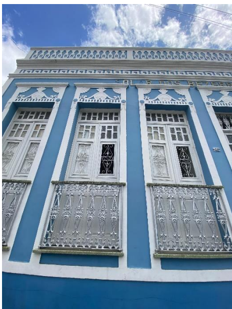
Figura 30: Detalhe das janelas e platibandas.
