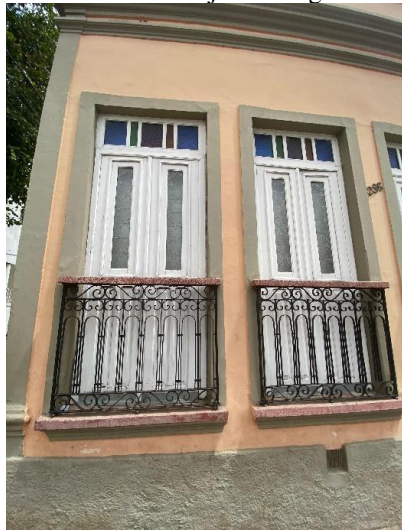
Figura 61: Detalhe das janelas e guarda-corpo.
