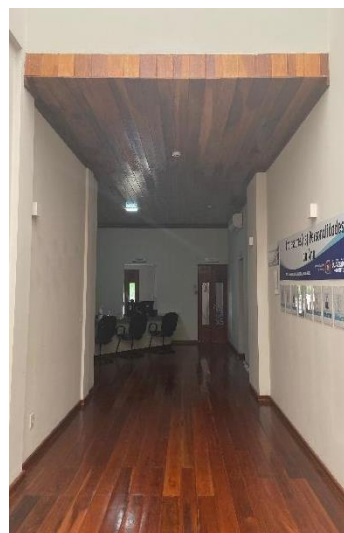
Figura 59: Forro e piso de madeira da Casa 376.
