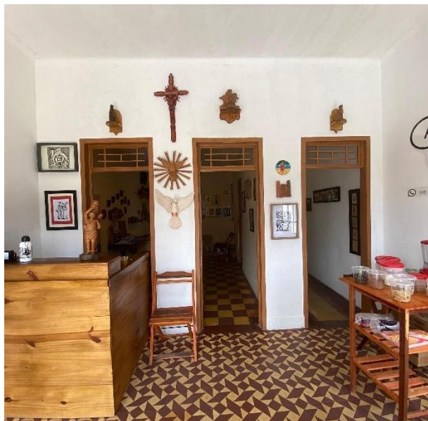
Figura 68: Esquadrias originais de madeira.
