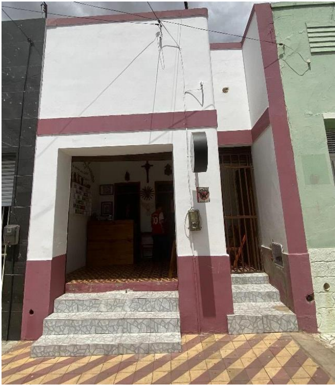
Figura 65: Fachada da Casa 308.
