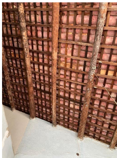
Figura 36: Madeiramento original de carnaúba.
