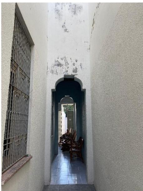
Figura 33: Arcos no interior da casa, fazendo a divisão dos cômodos.
