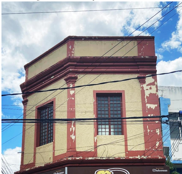
Figura 64: Detalhe das janelas do Sobrado 203.
